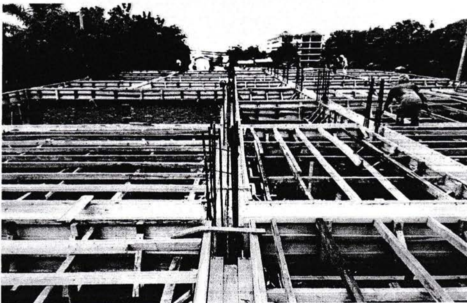
Gambar 3.3.2 Pengerjaan bekisting kolom
