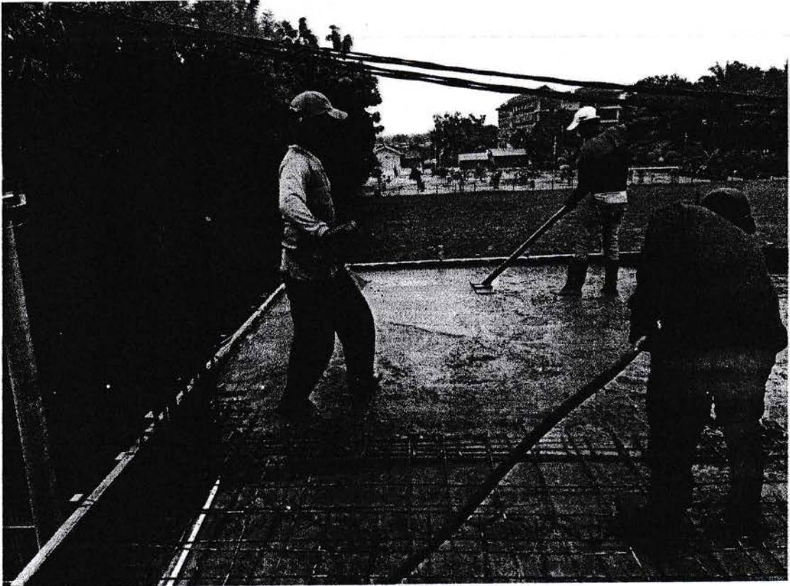
Gambar 3.7 Pengecoran pelat lantai
