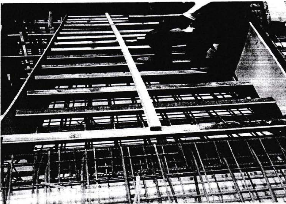
Gambar 3.3.2 Pengerjaan bekisting kolom
