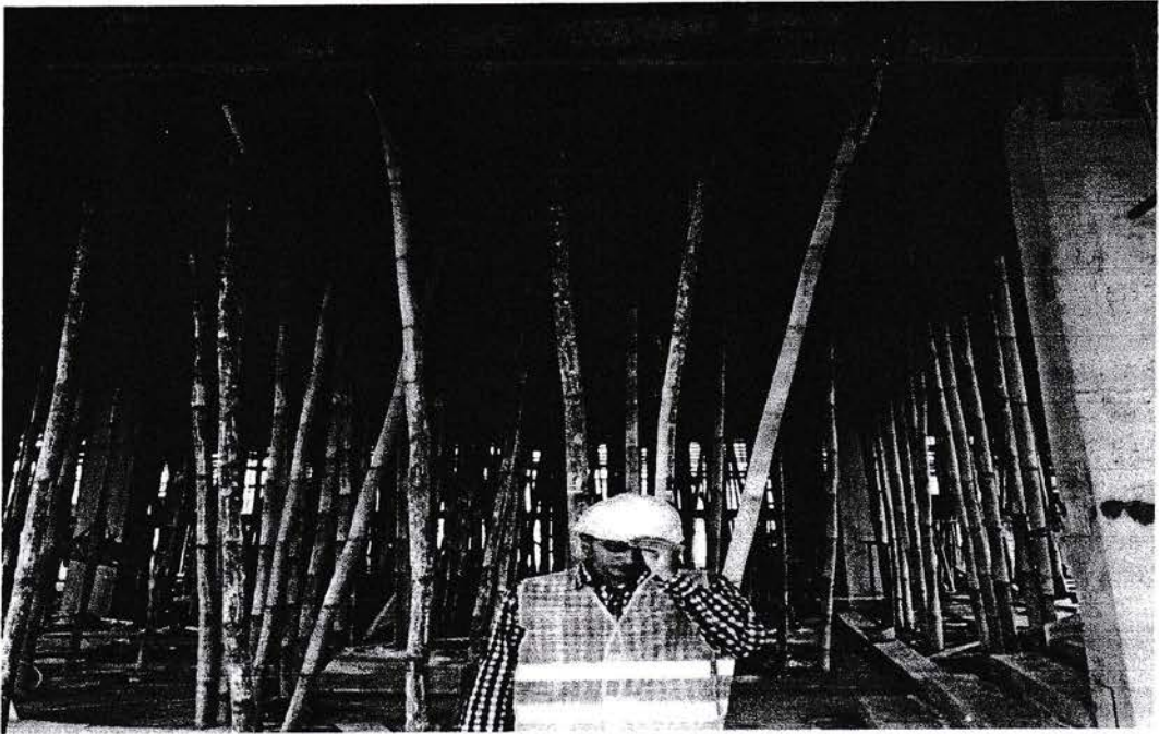
Gambar 3.4.6 Perancah Bambu
