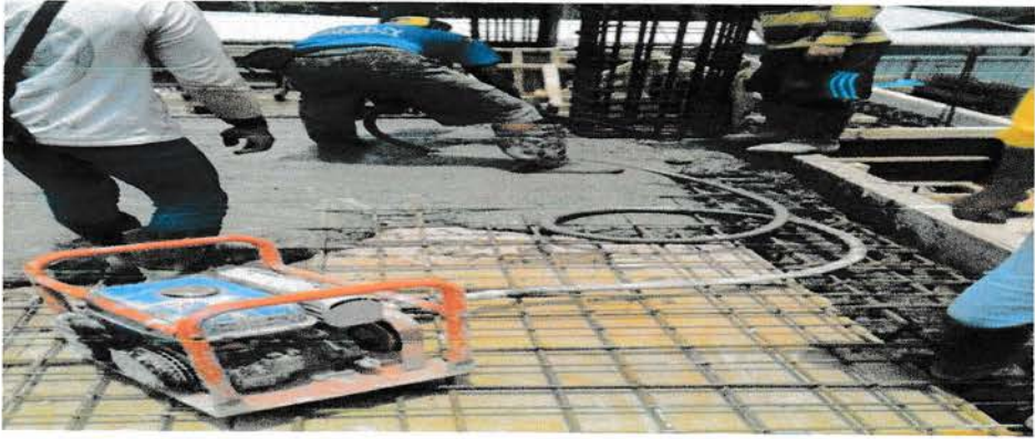
Gambar 2.17 Pengecoran Plat Lantai
