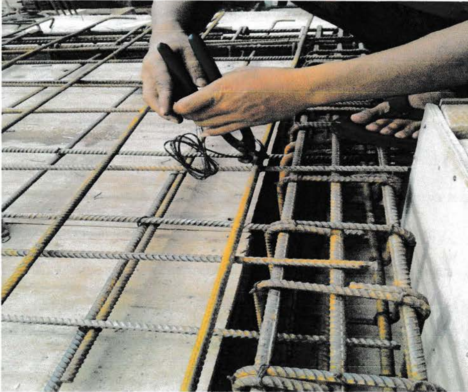
Gambar 2.16 Pembesian Plat Lantai
