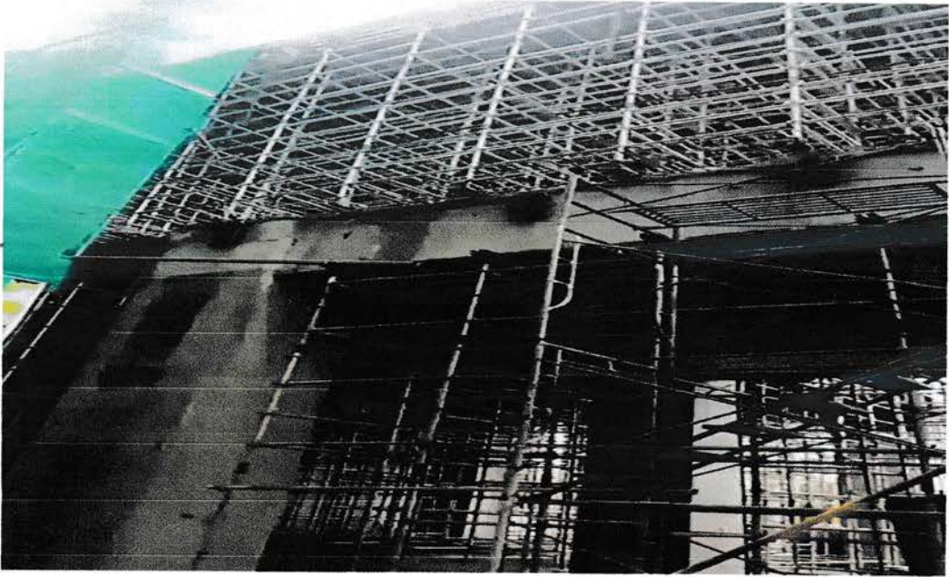
Gambar 2.15 Pemasangan Bekisting Balok dan Plat Lantai
