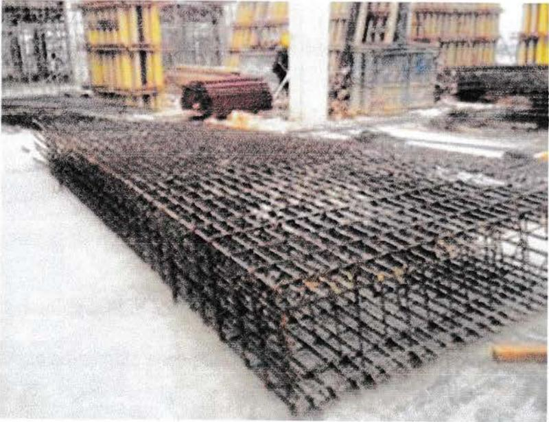
Gambar 4.14 pemasangan tulangan kolom
