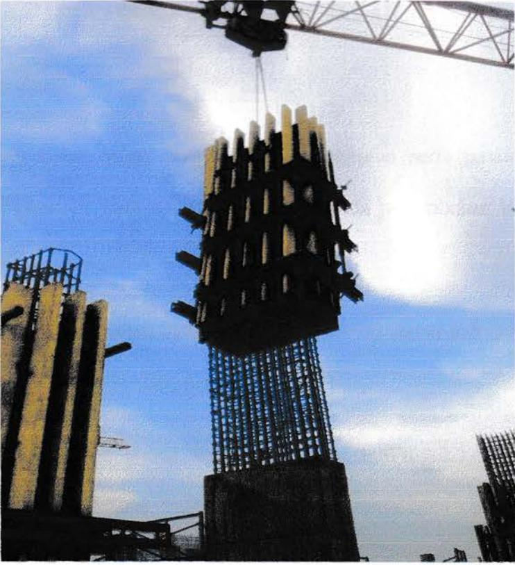
Gambar 4.17 pembongkaran bekisting kolom
