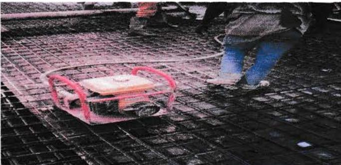
Gambar 4.3 mesin Vibrator
