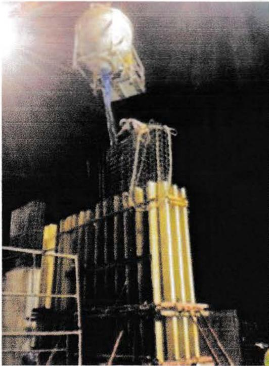
Gambar 4.16 pengecoran kolom
