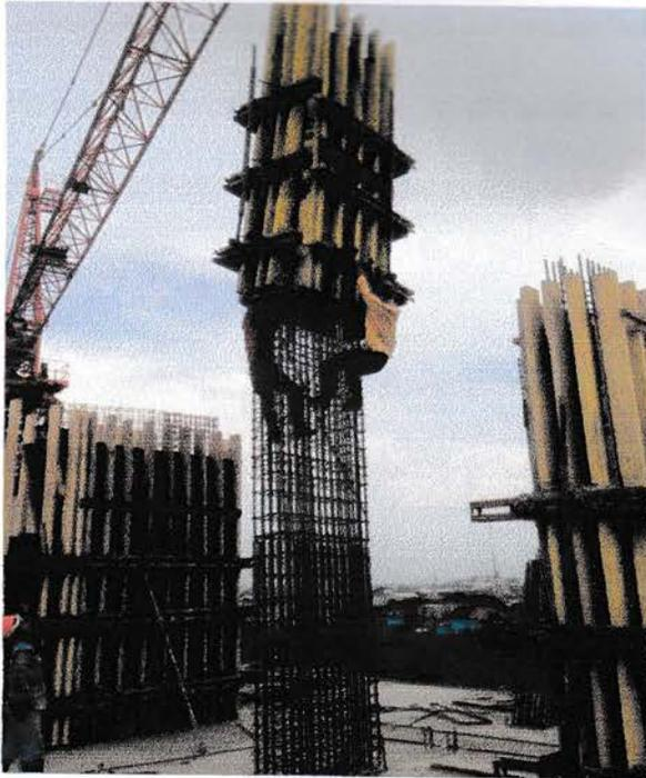
Gambar 4.15 pemasangan bekisting kolom
