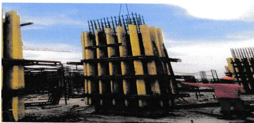
Gambar 3.1 bekisting kolom (bekisting dinding peri)
