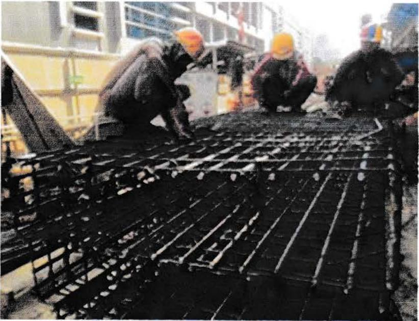
Gambar 4.13 pembuatan tulangan kolom
