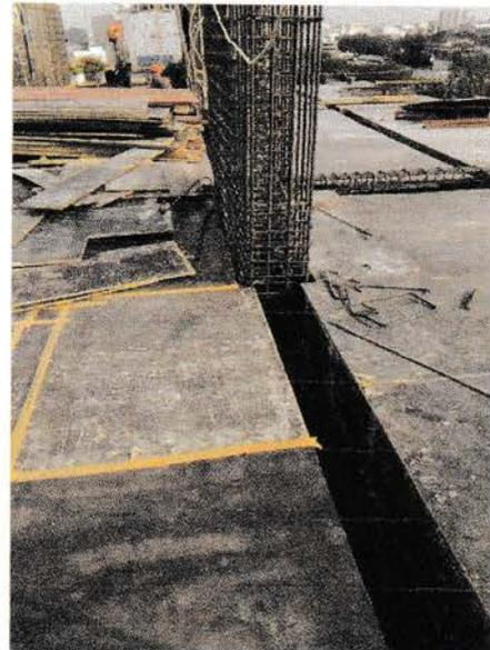
Gambar: Pemasangan Bekisting Plat
