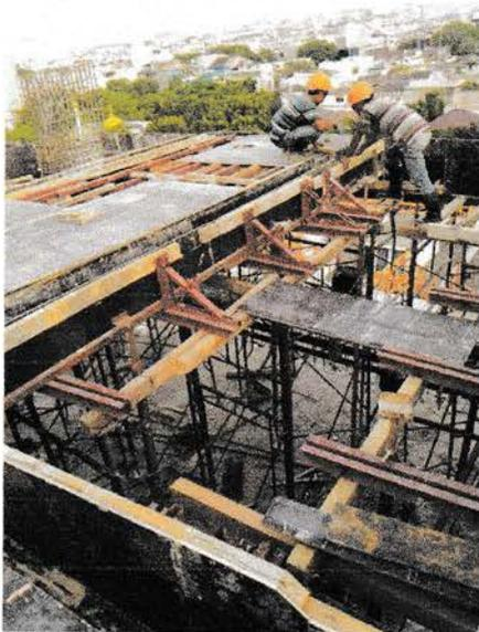
Gambar : Pemasangan Bekisting Balok
