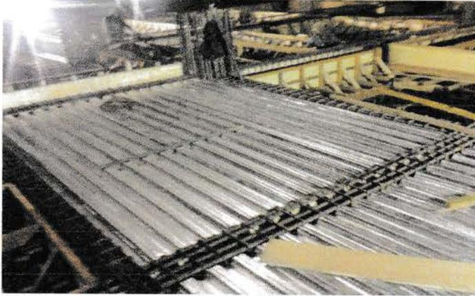
**Gambar 3.3. Bekisting plat lantai(Sumber : Data Lapangan 2016)**
