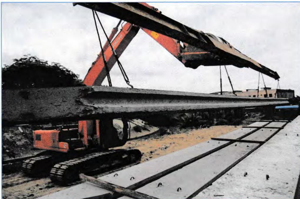
**Penurunan Sheet Pile Beton dari Trailer dengan menggunakan Excavator**
