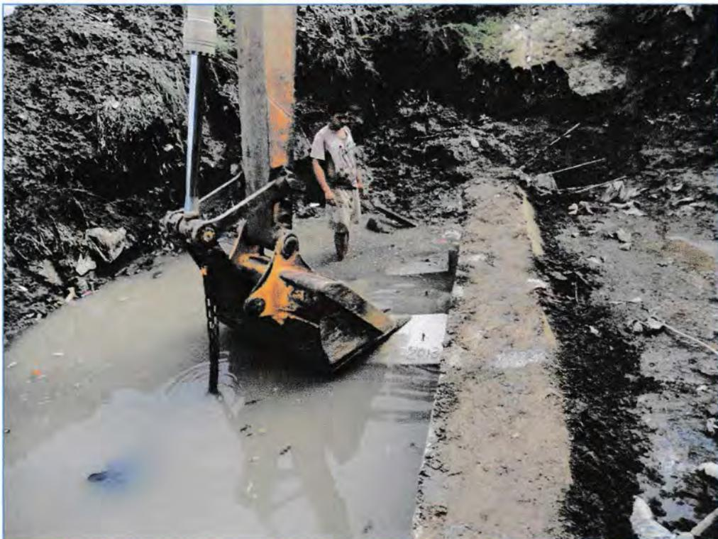
**Pemasangan / Penyusunan Blok Beton**
