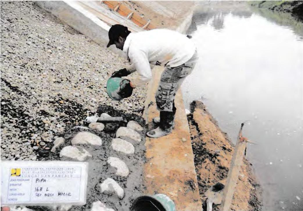
**Pasangan Batu dan Pemasangan Pipa Drainase pada Slope Protection**
