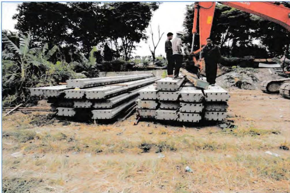
**Penyusunan Sheet Pile Beton sebelum dilakukan Pemancangan**
