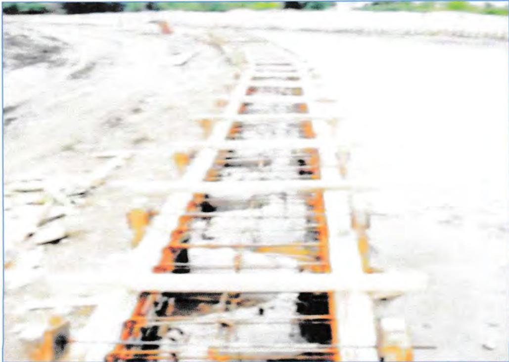
**Pemasangan Besi dan Bekisting Balok Pile Cap**
