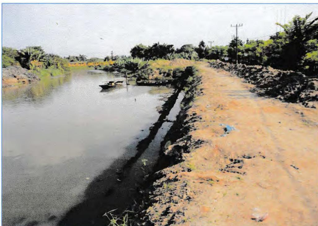
**Kondisi Sheet Pile yang Terpancang setelah dilakukan Pemotongan**
