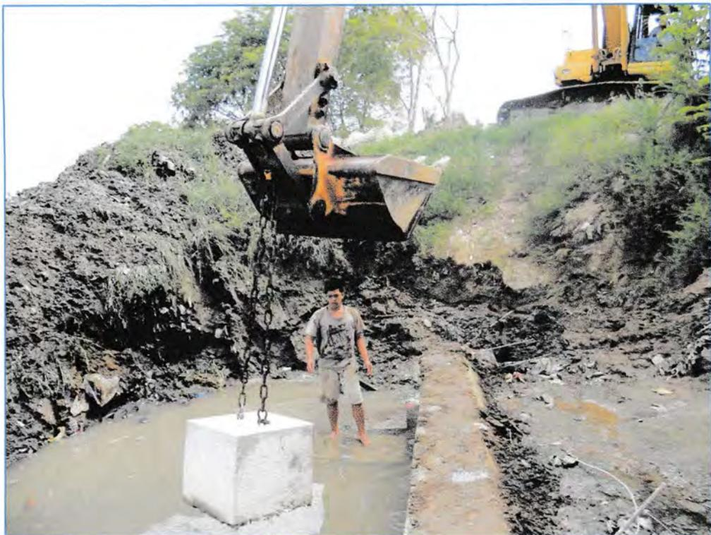
**Pemasangan / Penyusunan Blok Beton**
