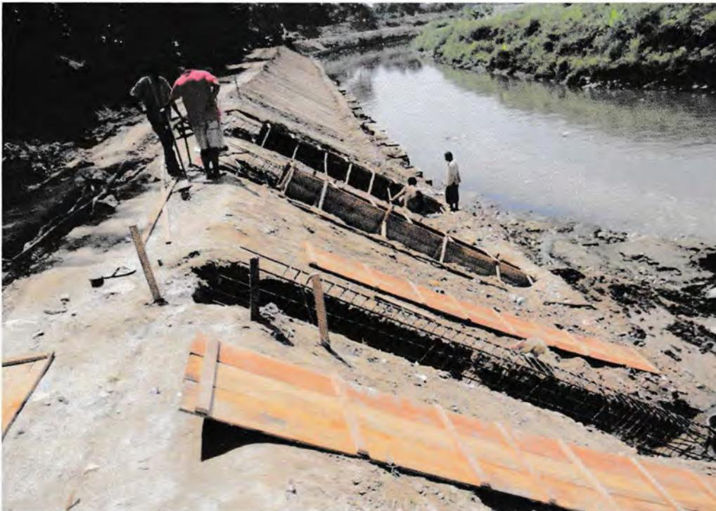
**Pemasangan Tulangan dan Bekisting Balok Slope**
