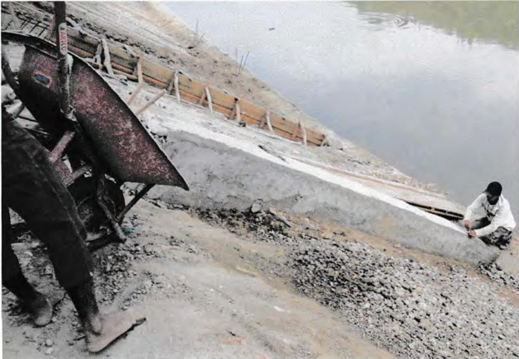
**Pembongkaran Bekisting Balok Slope Setelah Selesai Pengecoran**
