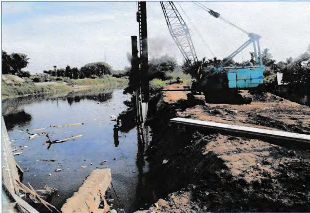
**Pemancangan Sheet Pile Beton**
