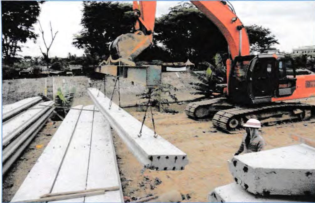
**Penanganan Sheet Pile Beton ( handling ) di Lokasi Penumpukan Sementara**
