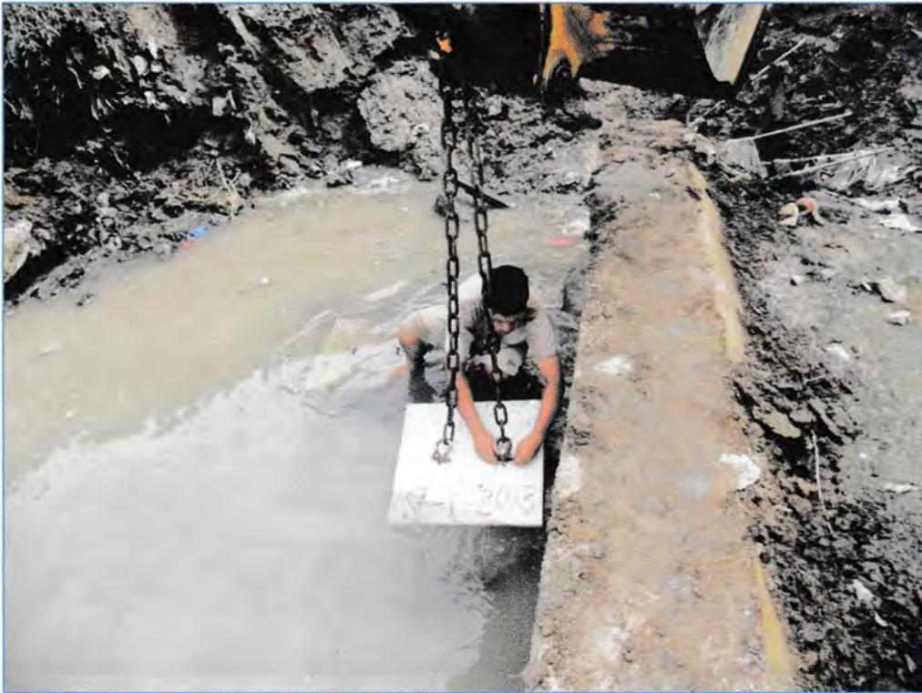
**Pemasangan / Penyusunan Blok Beton**
