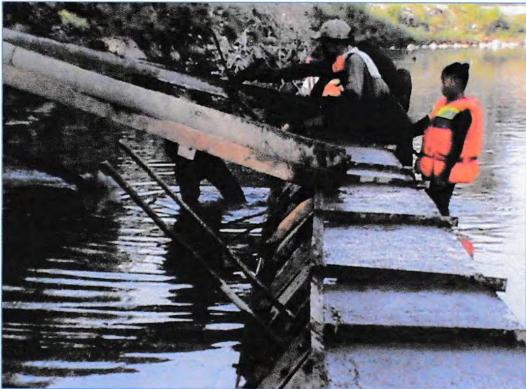
**Pengecoran Balok Pile Cap**
