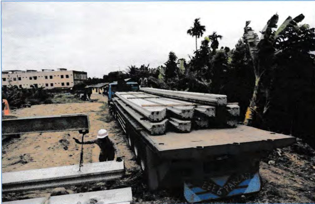
**Pengiriman Material Sheet Pile Beton dari Pabrik ke Lokasi Pekerjaan**
