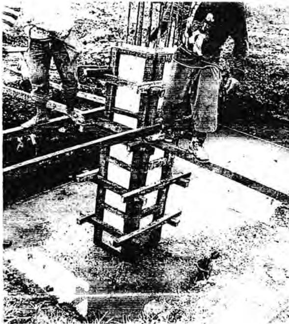
**Gambar 3.2.5.2 Pengecoran Kolom**
