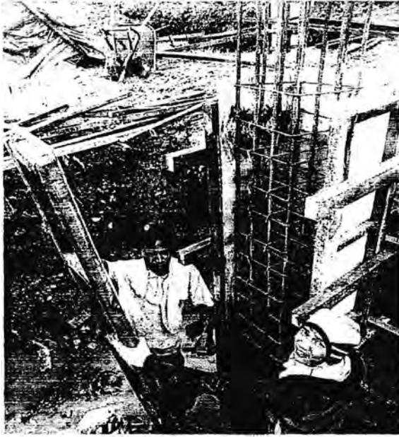
**Gambar 3.2.4.1 Pemasangan Papan Kayu Bekisting**
