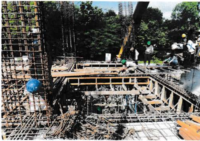
Gambar 2.23 (e) Pemasangan Tulangan
