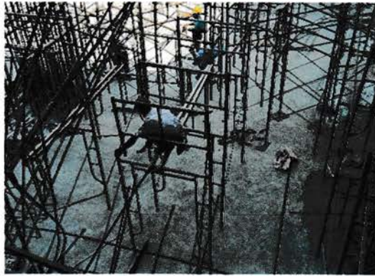
Gambar 2.23 (a) Pemasangan Perancah
