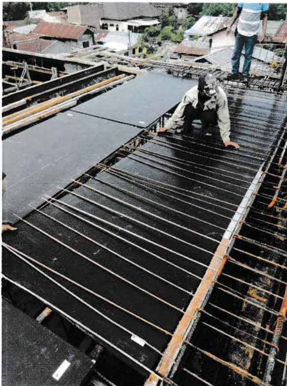
Gambar 2.23 (d) Pemasangan bekisting
