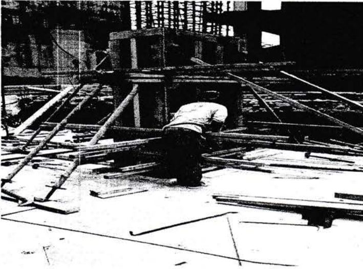
Gambar 2.8 : Bekisting Kolom
