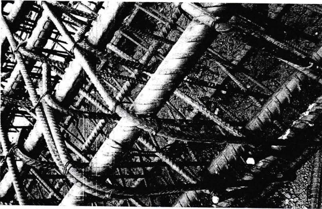
Gambar 7. Pembesian kolom dengan besi beton ulir ukuran 22 mm
