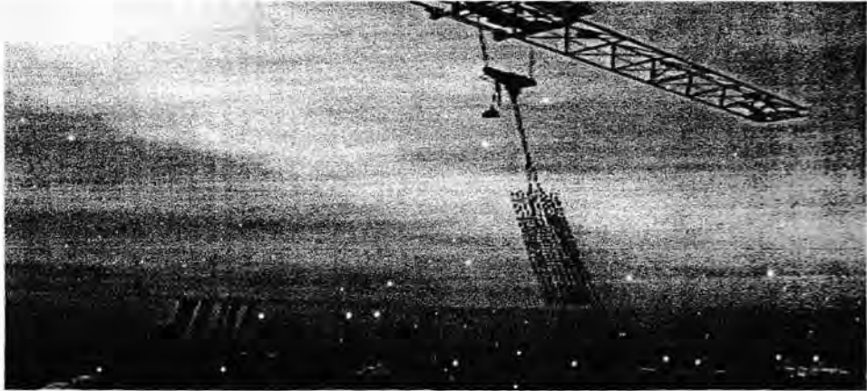
Gambar :Pengangkatan hasil perakitan tulangan kolom
