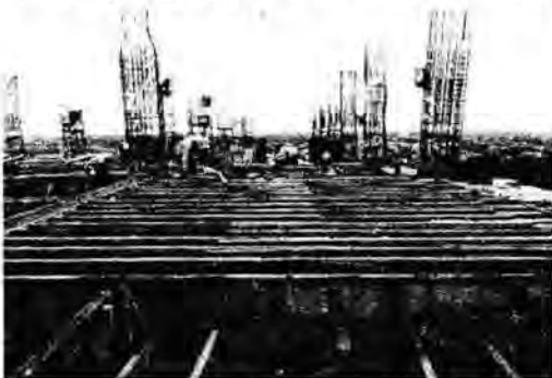
(a) Besi Hollow pemikul bekisting lantai
