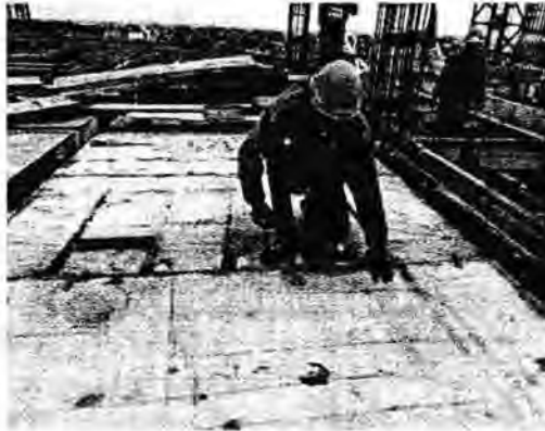
Gambar 4.13 Bekisting Sumber : Data Lapangan 2016
