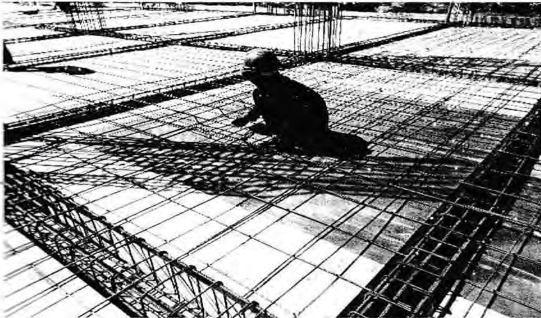
Gambar 3.7. Tulangan plat lantai
