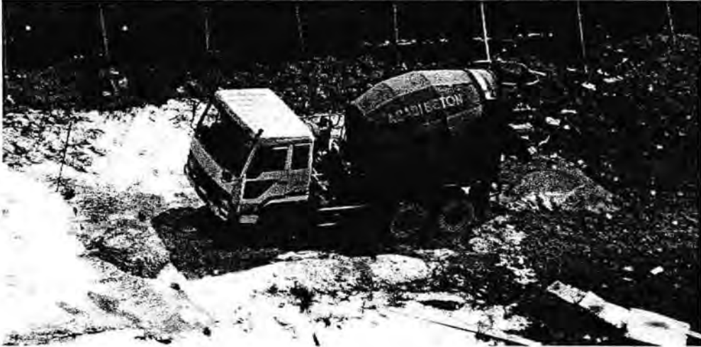
Gambar 3.8. pekerjaan adukan beton
