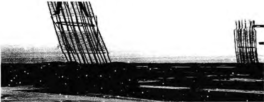
Gambar : Penyambungan tulangan kolom
