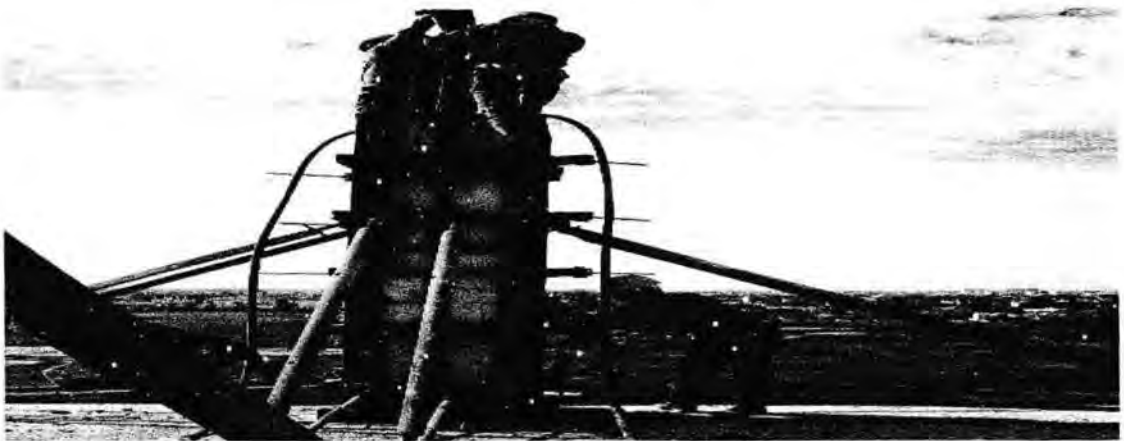
Gambar : Pemukulan sisi kolom dengan palu karet
