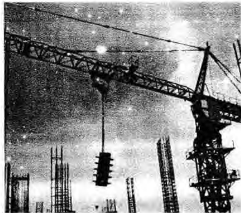
Gambar : Penyambungan tulangan kolom
