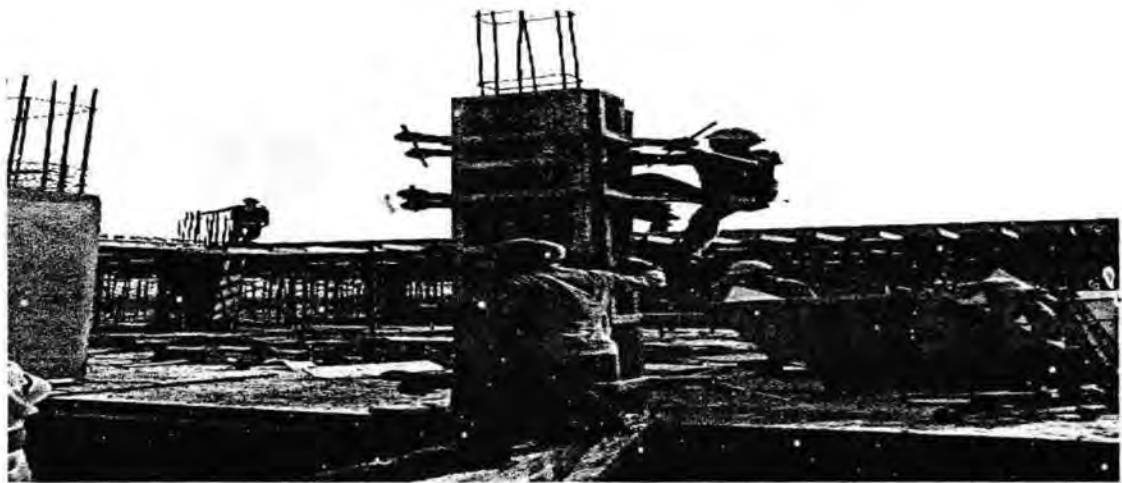
Gambar : Pembongkaran bekisting kolom
