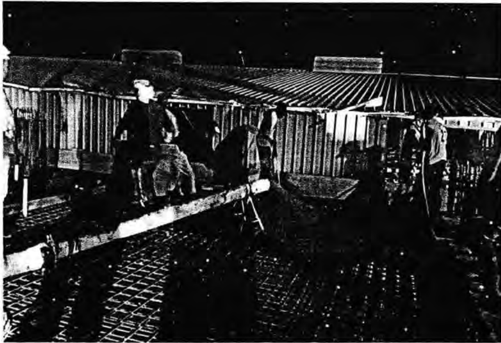
Gambar 3.9. pekerjaan pengecoran
