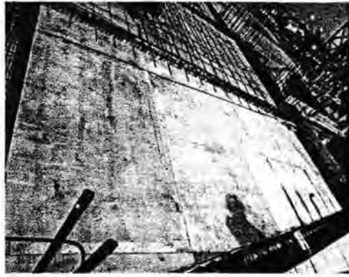
(d) Bekisting lantai siap dipasang penulangan
