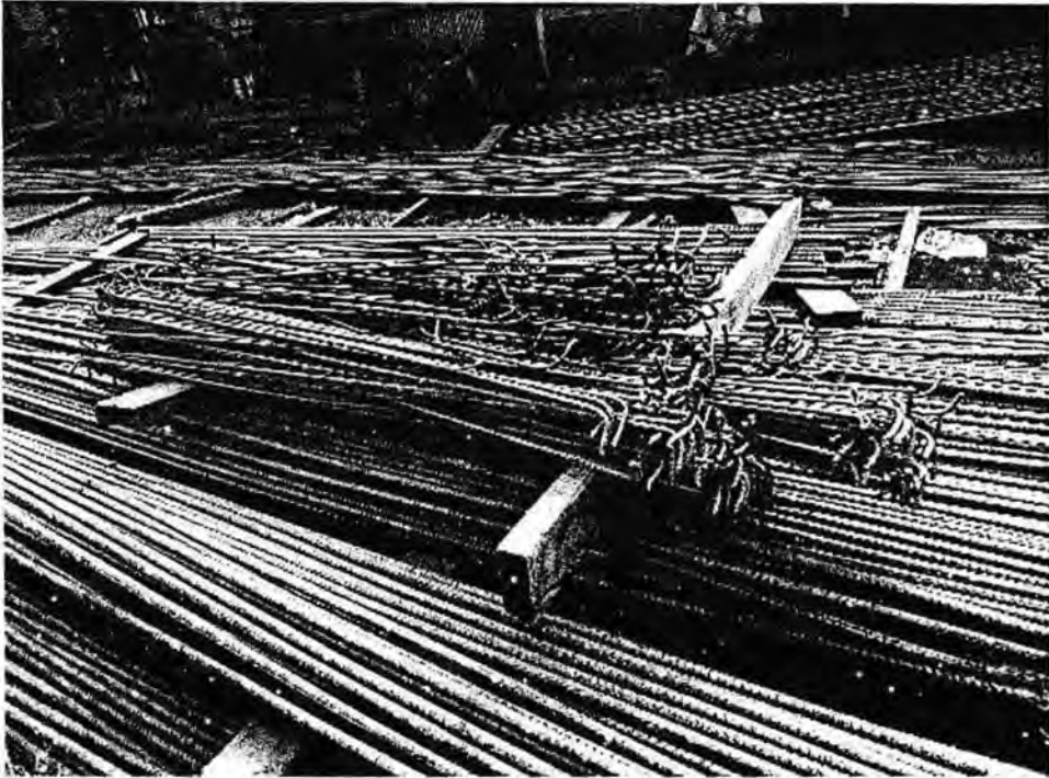
Gambar 4.7 Besi Beton Sumber : Data Lapangan 2016
