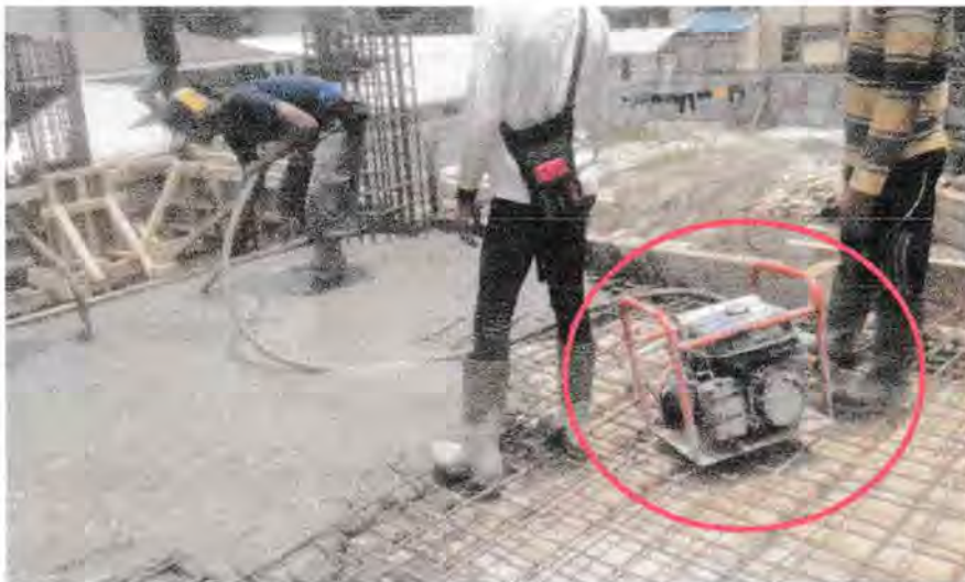
Gambar 3.3 Pemadatan cor menggunakan vibrator
