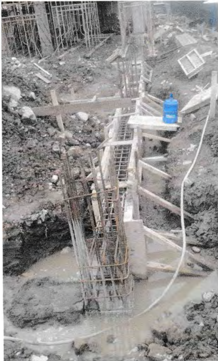
Gambar. Penampang Balok Sloof Dilapangan
