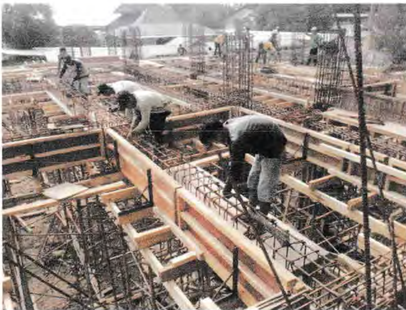
Gambar 3.7 Pekerjaan Pembesian Balok
