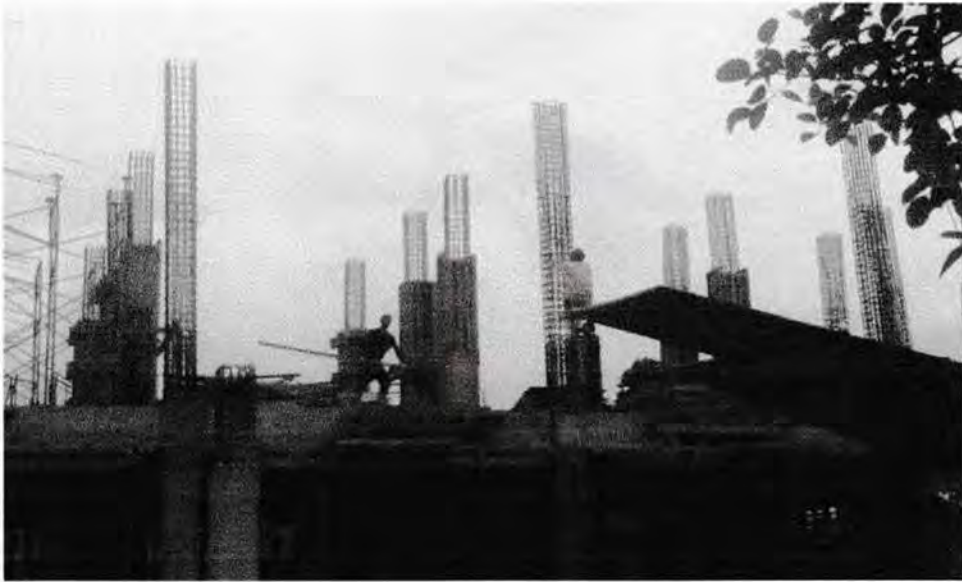
Gambar. Pemasangan Kolom Lt.III
