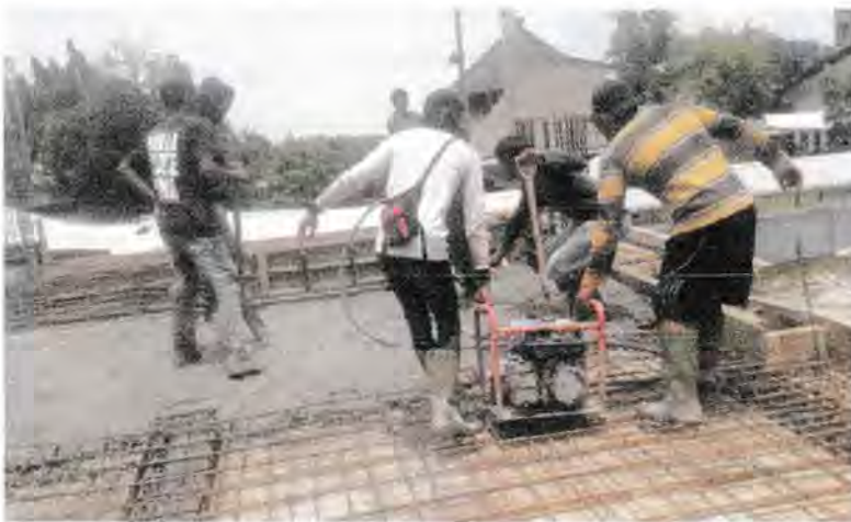
Gambar 3.8 Pekerjaan Pengecoran Balok dan Pelat
