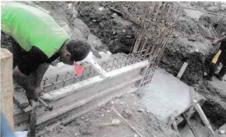
Gambar. Pemasangan Bekisting Balok Sloof
