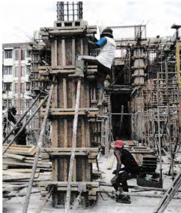
Gambar. Pemasangan Bekisting Kolom Lt.III
