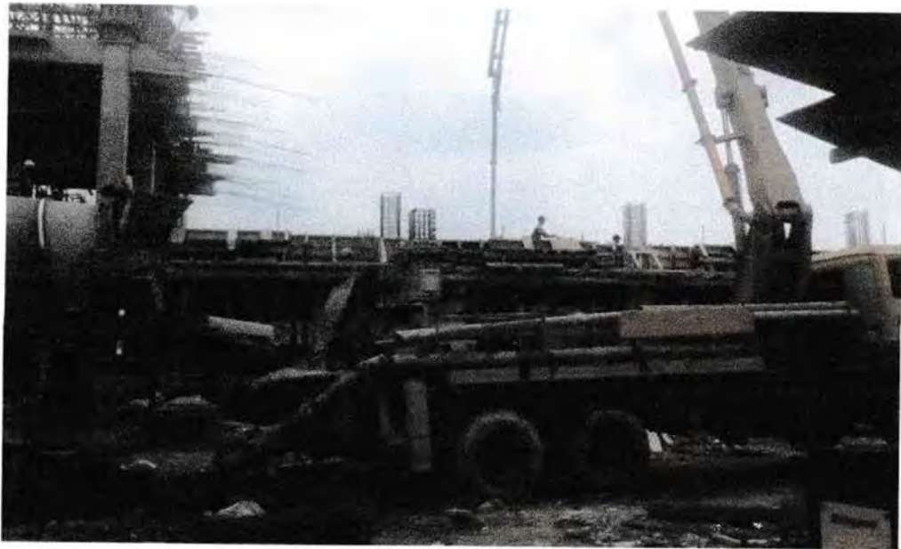
Gambar. Pengecoran Plat Lt.II
