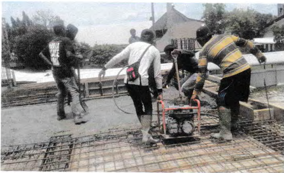
Gambar. Pemasangan Cor Menggunakan Vibrator
