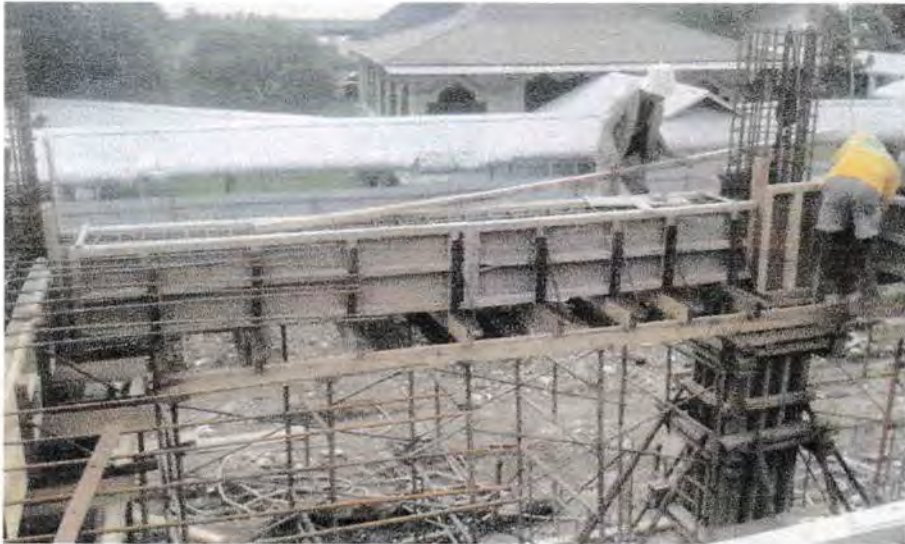
Gambar. Pemasangan Bekisting Balok Lt.II
