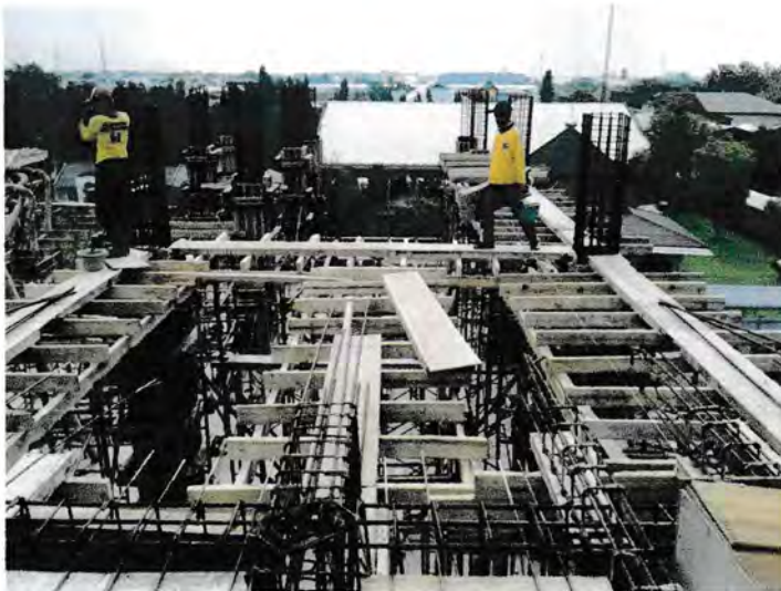
Gambar : proses pemasangan scaffolding
