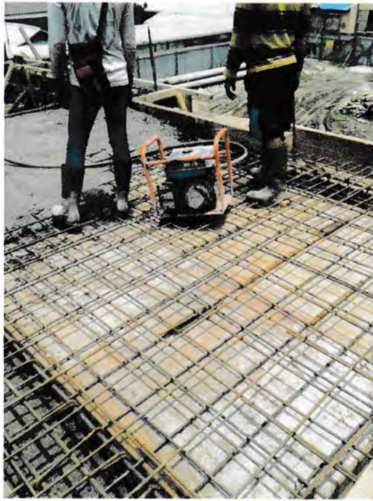
Gambar: proses pengecoran
