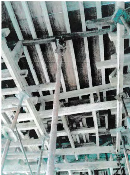
Gambar : tampak bawah pemasangan bekisting plat lantai
