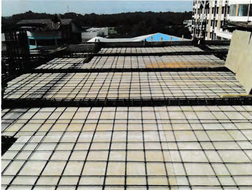
Gambar : Bekisting plat lantai
