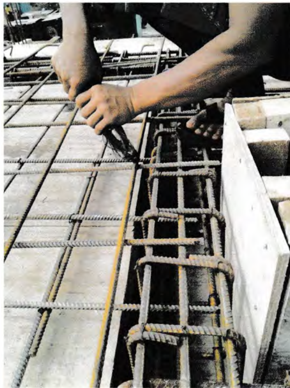
Gambar : prnyambungan besi plat lantai
