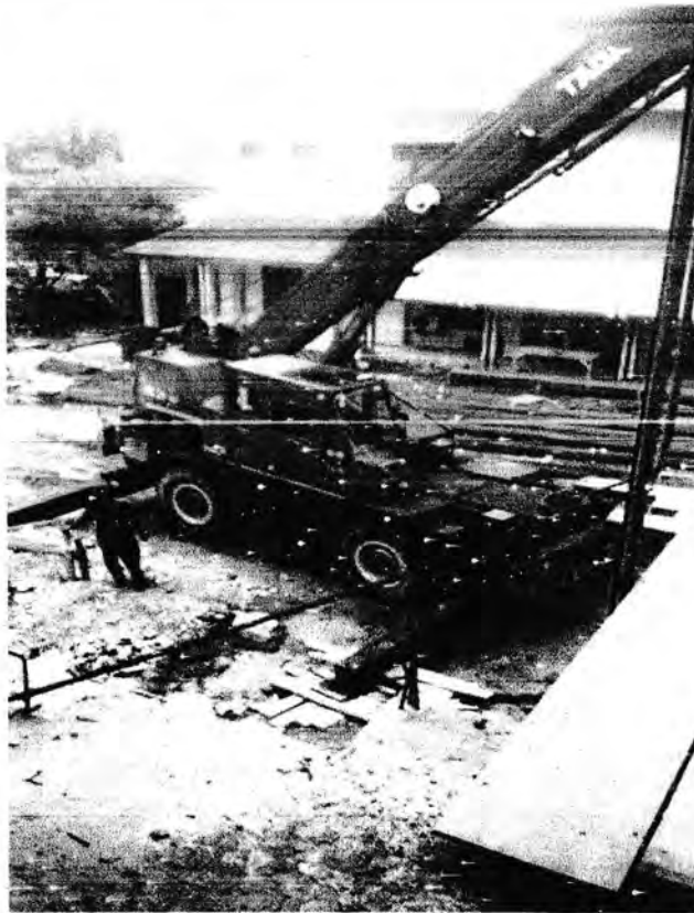
Gambar 3.3 Truck crane pada proyek PPPPTK
