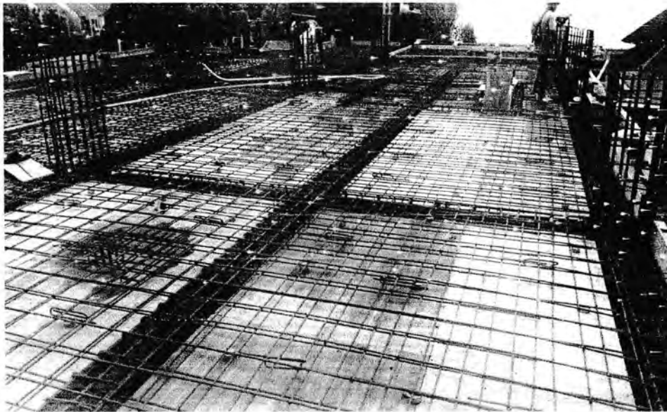
Gambar : kondisi penulangan pada lantai III
