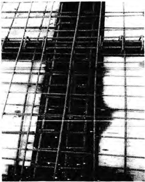
Gambar: pertemuan tulangan balok
