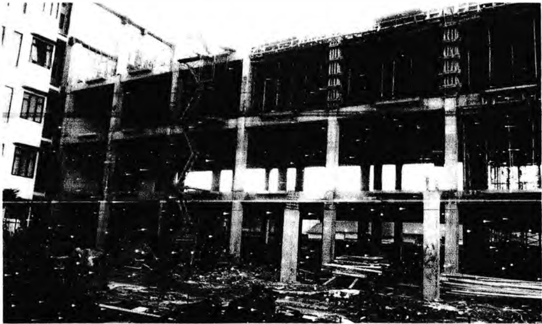
Gambar : kondisi pada proyek P4TK masih dalam proses lantai IV
