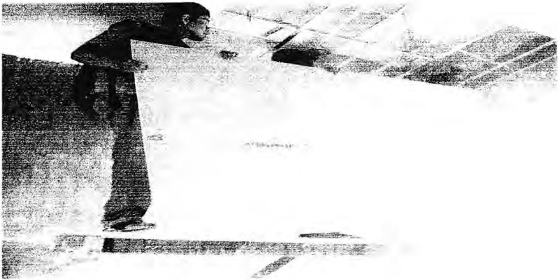
**Gambar 4.9. Pekerjaan Pemasangan Finising plafond Dengan Meuggunakan Gypsum**
