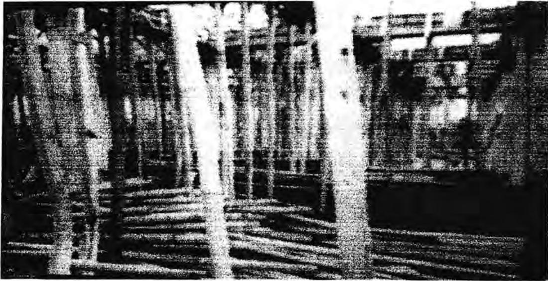
**Gambar 4.1. Pekerjaan pemasangan perancah**
