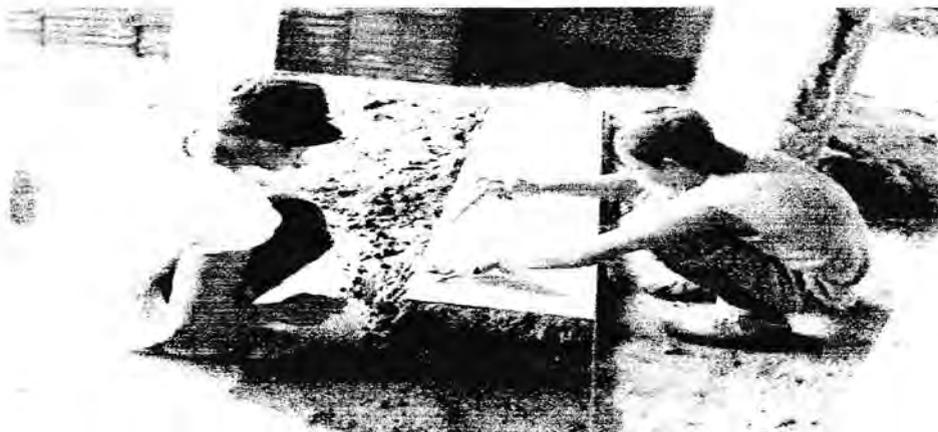
**Gambar 4.10. Pekerjaan Pemasangan lantai keramik pada lantai**
