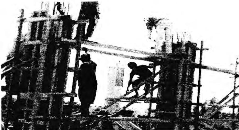
Gambar 4.6. Pembongkaran Bekisting
