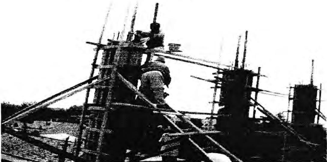
**Gambar 4.2. Pekerjaan Pemasangan Bekisting pada kolom.**
