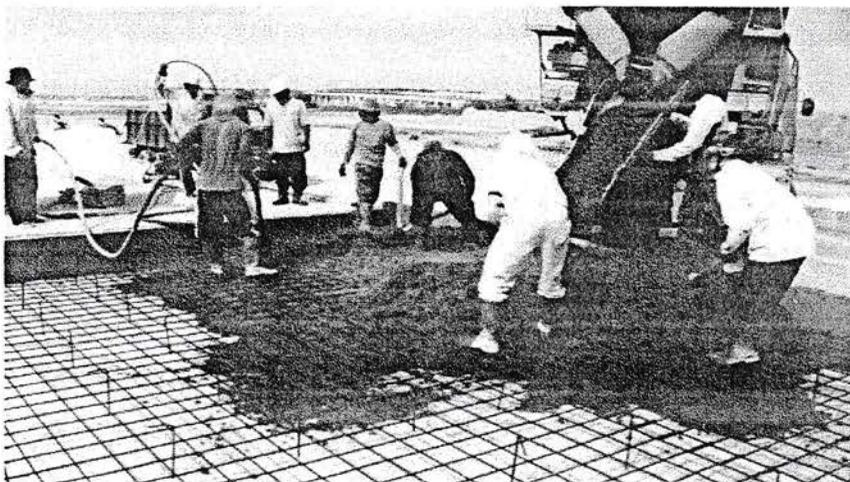
Gambar 3.11 : Pekerjaan penghamparan pada lapisan Rigid
