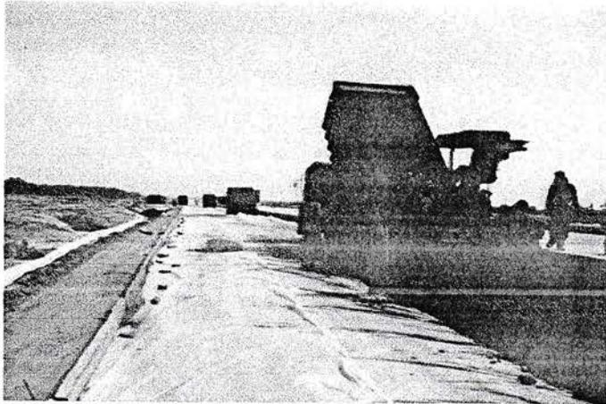
Gambar 3.8 : Pekerjaan pengecoran pada lapisan CTB
