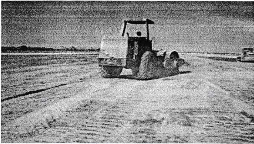
Pekerjaan Pemadatan lapisan Subgrade Taxiway
