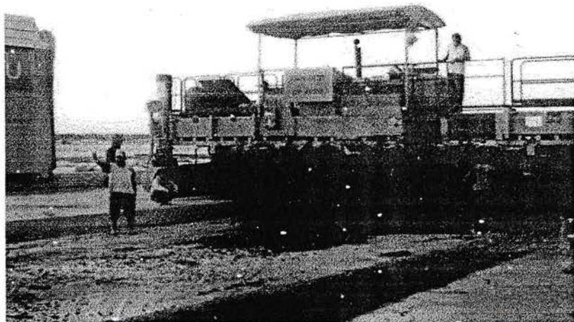
Gambar 3.12 : Pekerjaan pamadatan lapisan Rigid dengan alat Gomago Sumber : Data Lapangan 2010
