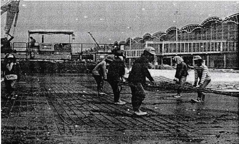
Gambar 3.14 : Pekerjaan pemasangan pada baja tulangan Sumber : Data Lapangan 2010
