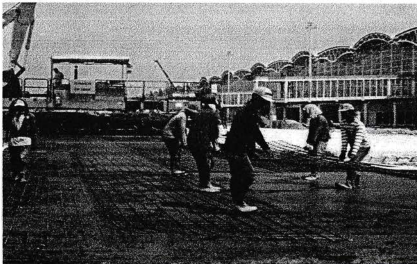
Pemasangan tulangan baja pada lapisan rigid Taxiway
