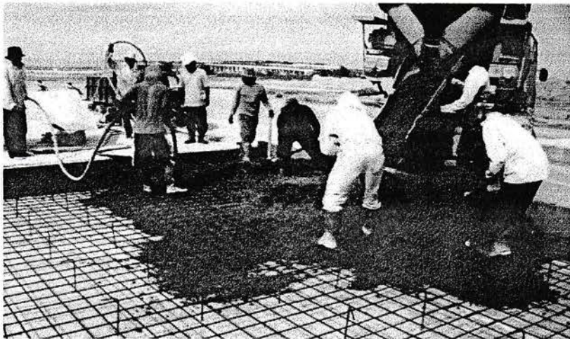
Pemasangan tulangan baja pada lapisan rigid Taxiway
