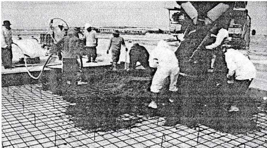
Gambar 3.11 ; Pekerjaan penghamparan pada lapisan Rigid Sumber : Data Lapangan 2010
