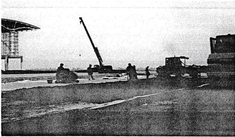
Pekerjaan lapisan CTB Taxiway
