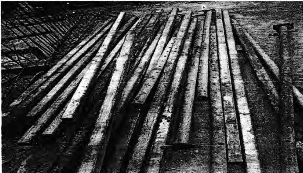
Gambar : Besi panjang (hollow)
