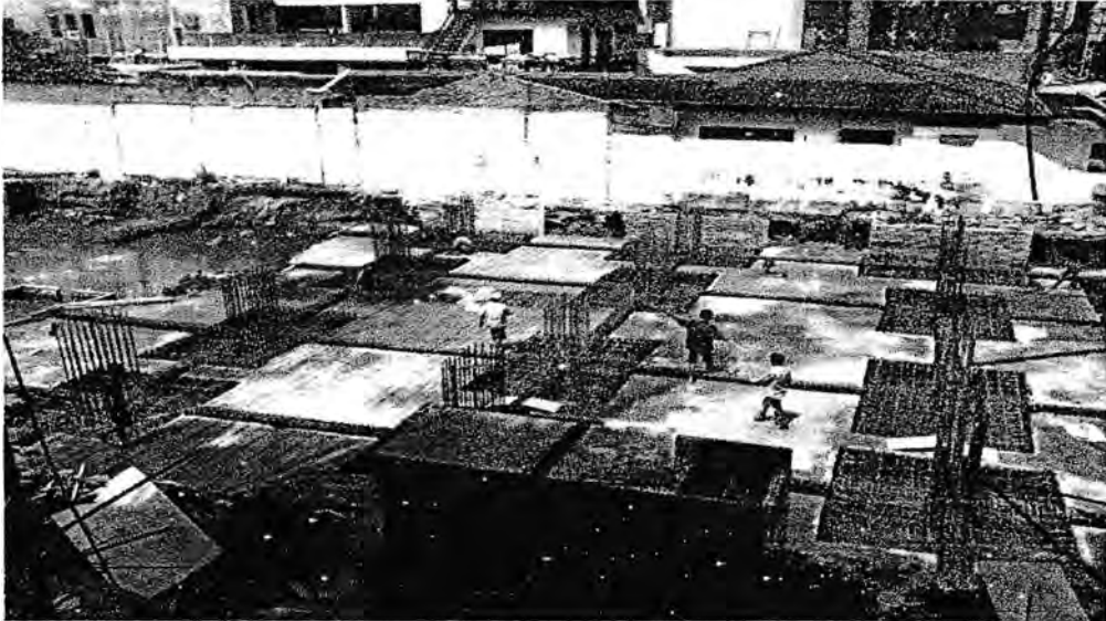
Gambar : Pondasi dan tiang kolom untuk pengikat balok sloof
