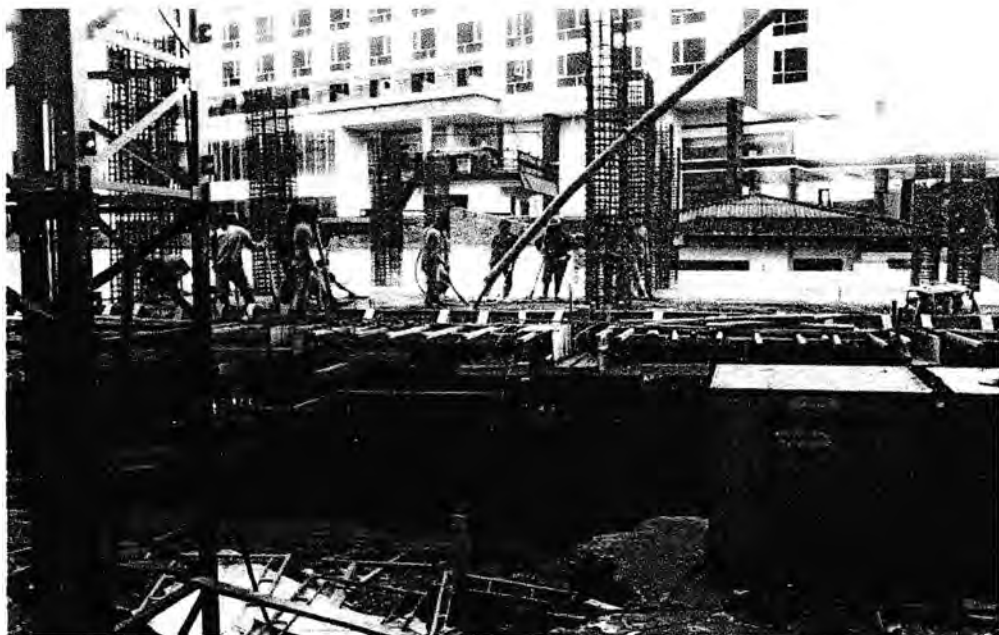
Gambar : Pekerjaan Pengecoran Pelat Lantai
