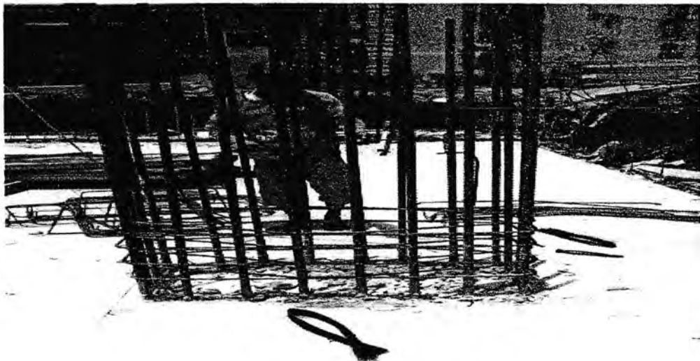
Gambar : Pengikatan Pembesian kolom dan pembegelan
