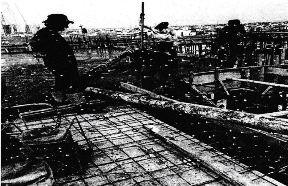
Gambar 1.2 Pengecoran plat lantai & balok
