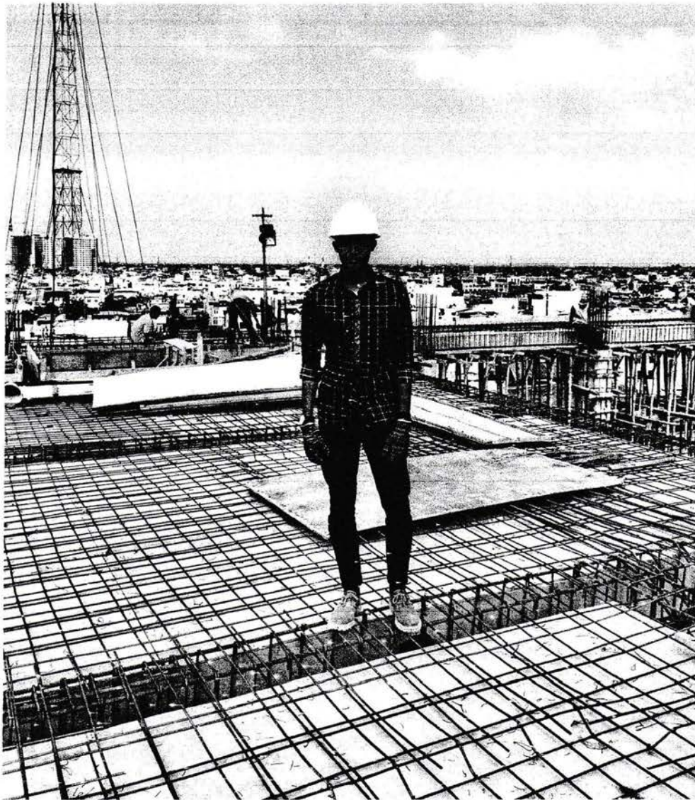
Gambar 3.15 Pemasangan Bekisting Balok dan Plat Lantai
