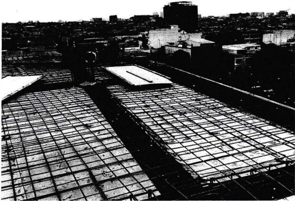
Gambar 1.8 pembesian, bekisting plat dan balok
