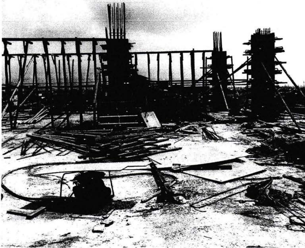
Gambar 3.18 Bekisting kolom
