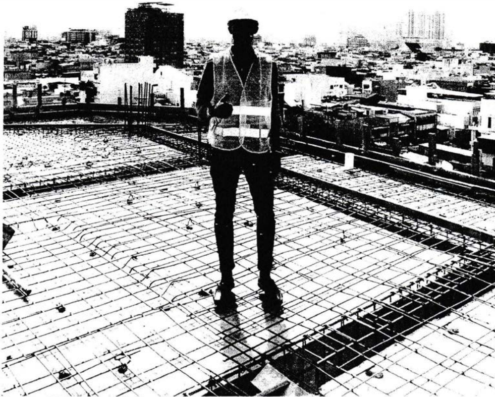
Gambar 3.23 Tulangan plat lantai
