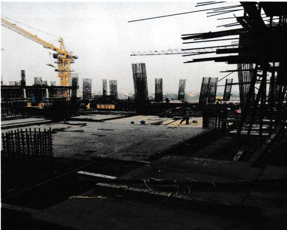
Gambar 5.5 Bekisting Lantai Sumber : Data lapangan ,2016
