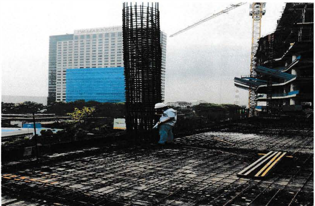
Gambar 5.12 Pembesian Kolom Sumber : Data lapangan ,2016
