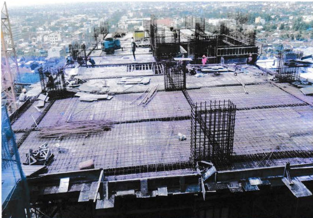
Gambar 4.1 Tampak atas pelat lantai yang diamati
