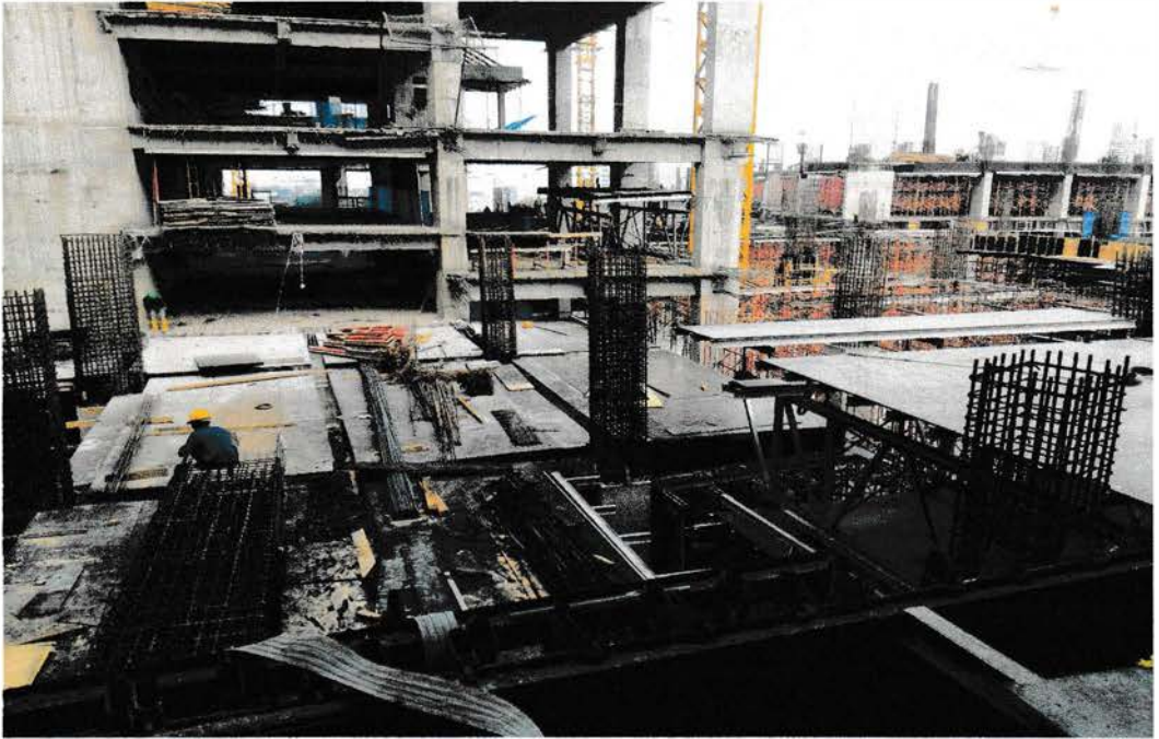
Gambar 5.15 Bekisting Lantai Sumber : Data lapangan ,2016
