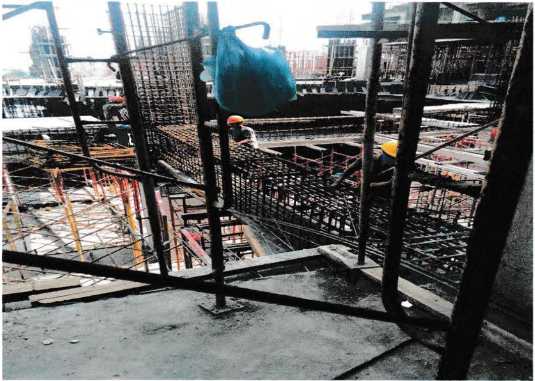
Gambar 5.11 Pembesian Balok Sumber : Data lapangan ,2016
