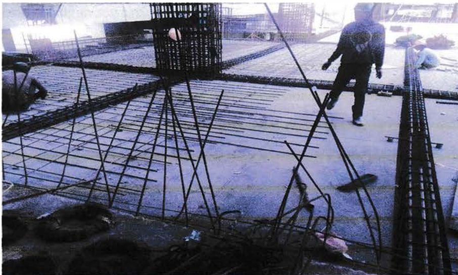
Gambar 3.17 Bekisting Plat Lantai Sumber : Data lapangan ,2017
