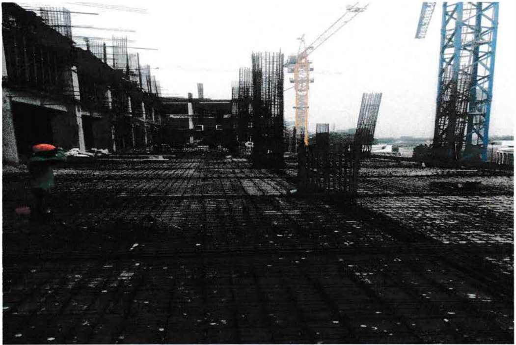
Gambar 5.1 Pembesian Lantai Sumber : Data lapangan ,2016
