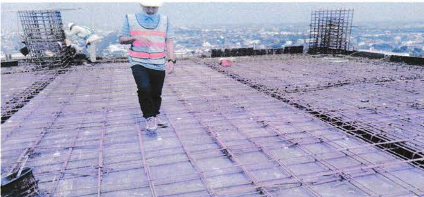
Gambar 3.8 Pembesian Lantai Sumber : Data lapangan ,2017
