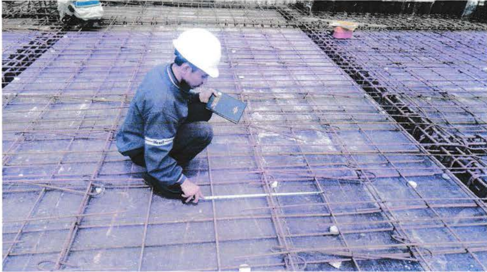
Gambar 3.19 Pembesian Plat Lantai Sumber : Data lapangan ,2017
