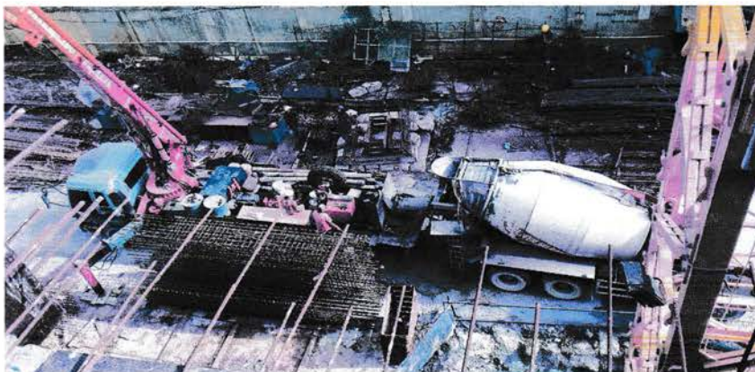
Gambar 3.2 Beton ready mix (Semen Merah Putra, Kraton) Sumber : Data lapangan ,2017
