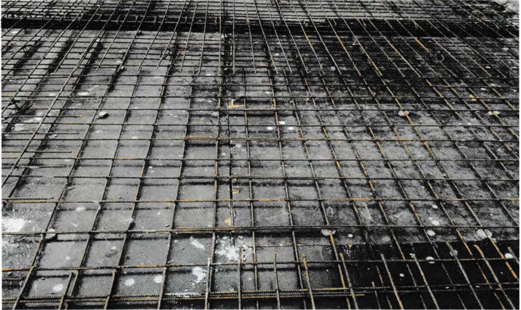
Gambar 5.7 Pembesian Lantai Sumber : Data lapangan ,2016
