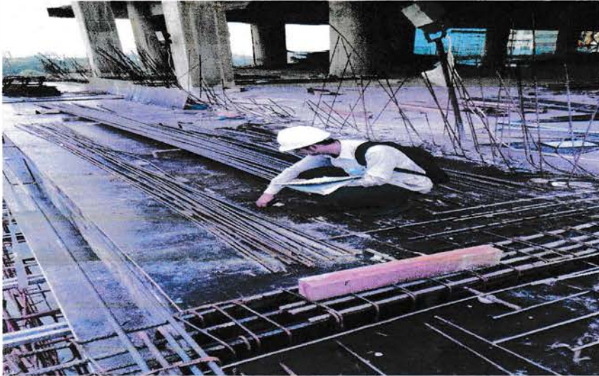
Gambar 3.15 Bekisting Lantai Sumber : Data lapangan ,2017
