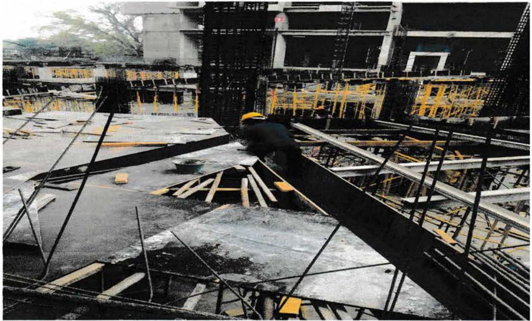
Gambar 5.13 Bekisting Balok Dan Lantai Sumber : Data lapangan ,2016
