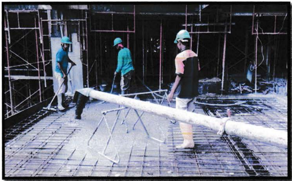
Gambar 3.20 Pengecoran Plat Lantai Sumber : Data lapangan ,2017
