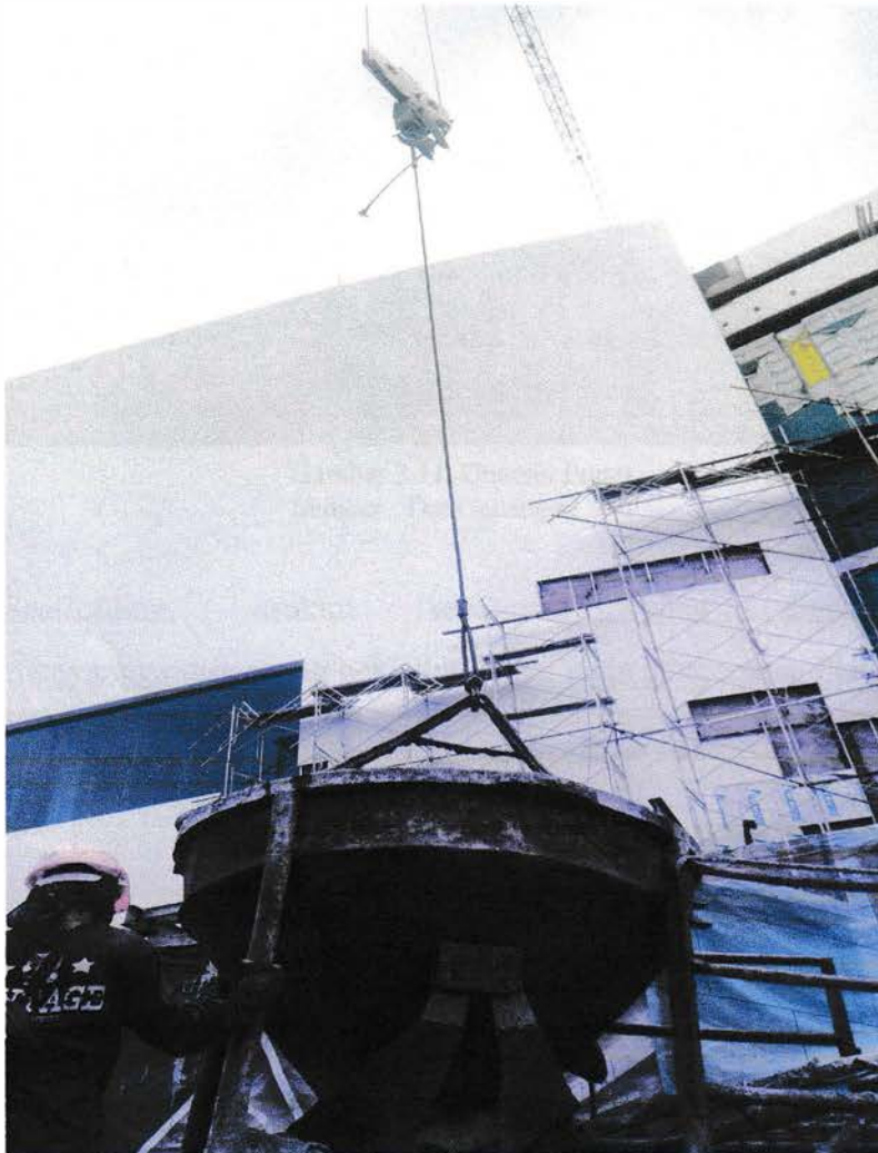
Gambar 3.10 Bucket Cor Sumber : Data lapangan ,2017
