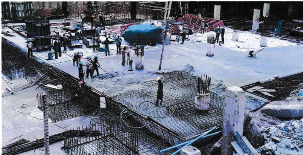
Gambar 3.18 Pengecoran Plat Lantai Sumber : Data lapangan, 2017
