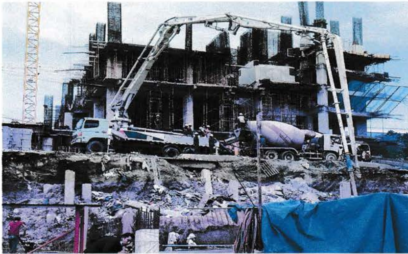
Gambar 3.11. Concret Pump Sumber : Data lapangan ,2017
