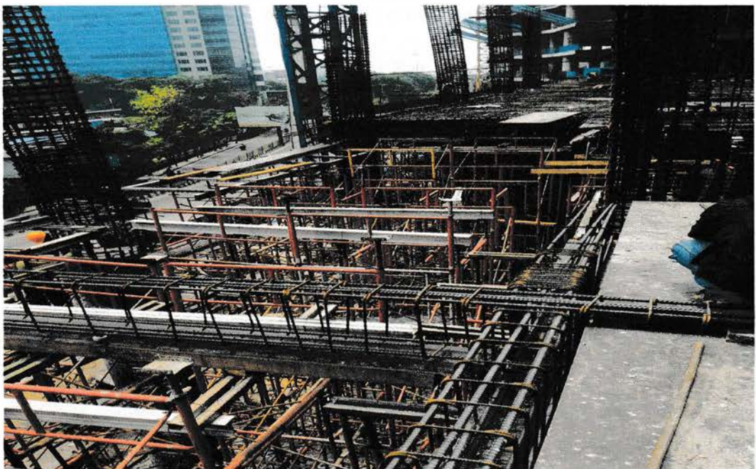
Gambar 5.8 Scaffolding Lantai Dan Balok Sumber : Data lapangan ,2016
