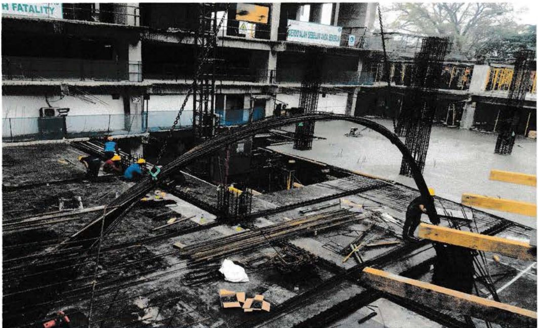
Gambar 5.2 Pembesian Lantai Sumber : Data lapangan ,2016
