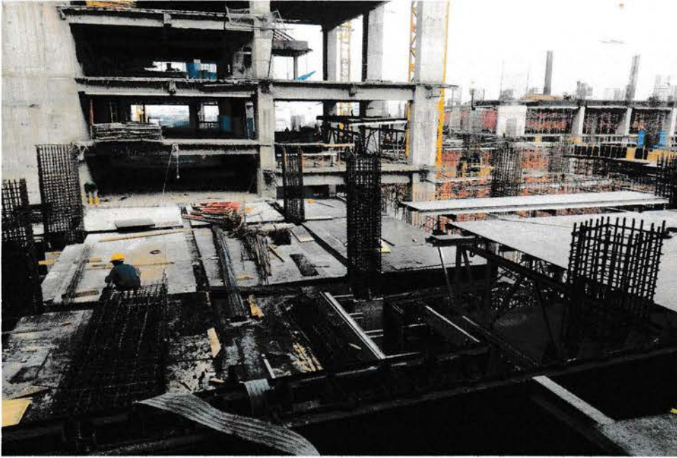
Gambar 5.5 Bekisting Lantai Sumber : Data lapangan ,2016
