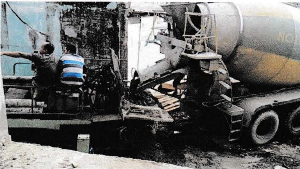
Concrete mix menunangkan mortar ke pump concrete
