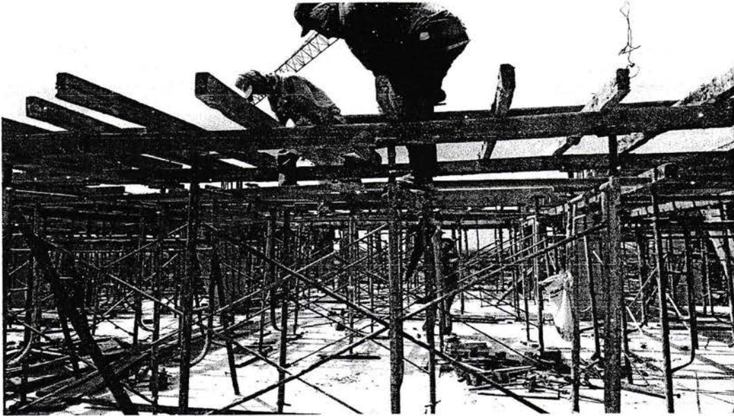
Gambar 3.5.3 Pemasangan Bekisting Balok dan Plat Lantai
