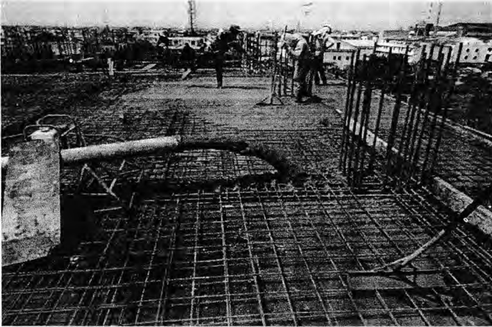
Gambar: 3.1.4.c Pengecoran dan pepadatan
