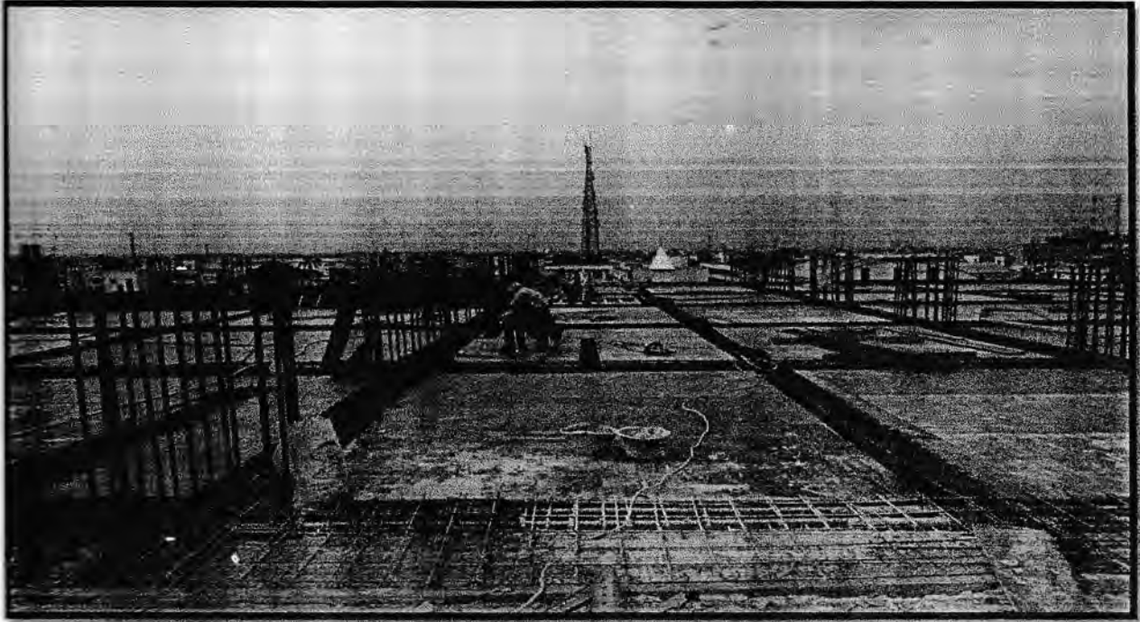
Gambar. Pemasangan mall lantai
