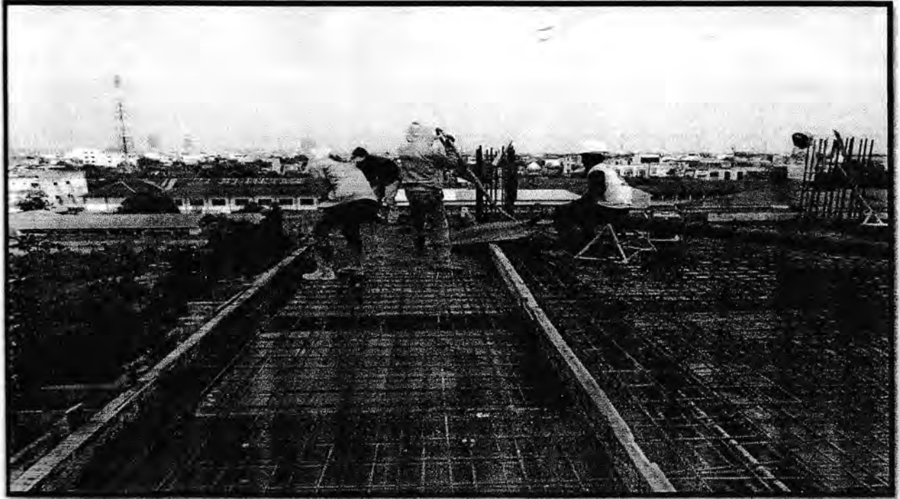
Gambar. Pengecoran Plat Lantai dan Pemasangan Beton
