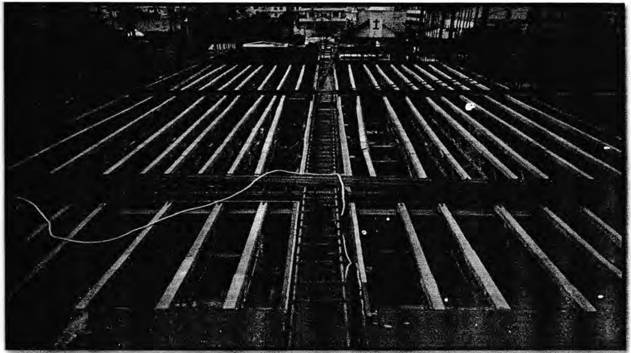
Gambar. Pemasangan orimbim
