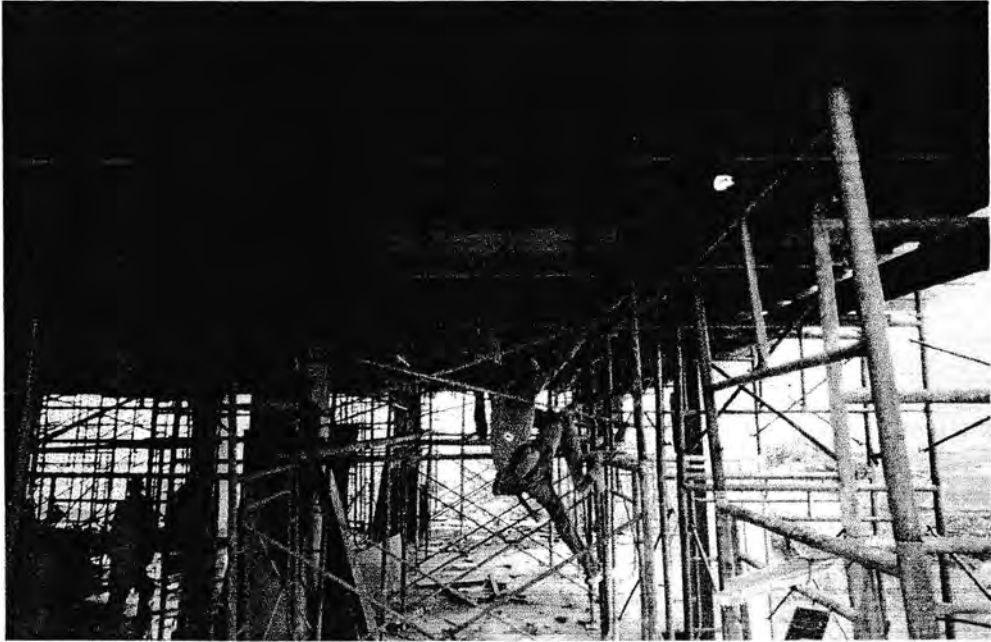
Gambar: 3.1.4 pembongkaran bekisting pada plat lantai
