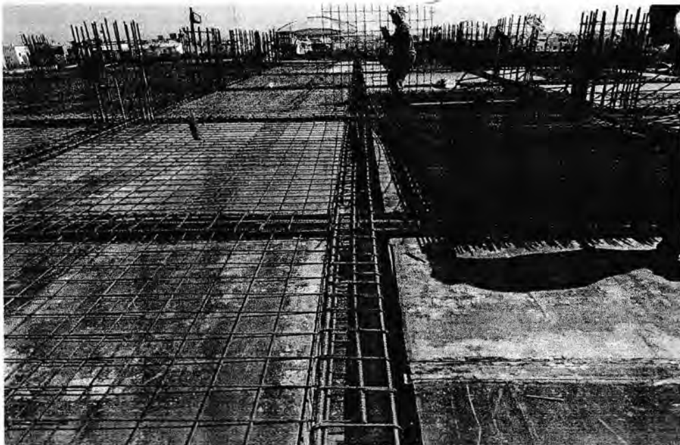
Gambar: 3.1.2. Pekerjaan pemasangan tulangan plat wiremesh
