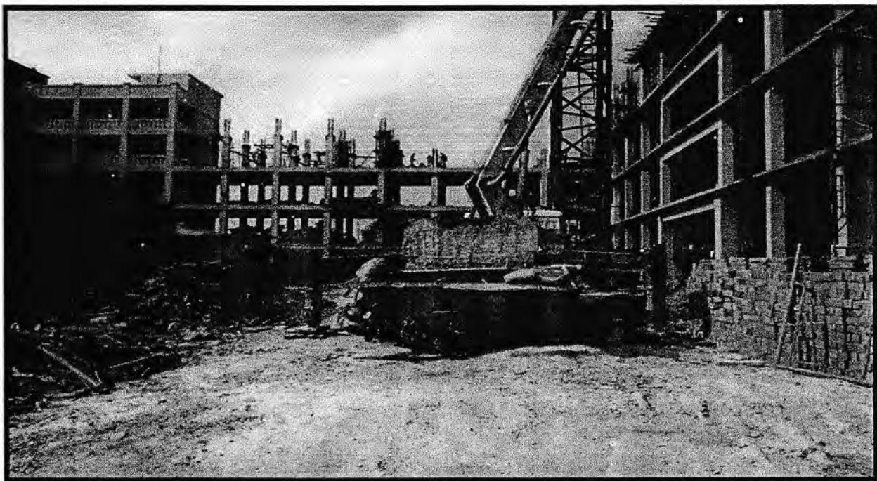
Gambar. Tampak Depan Bangunan Gedung
