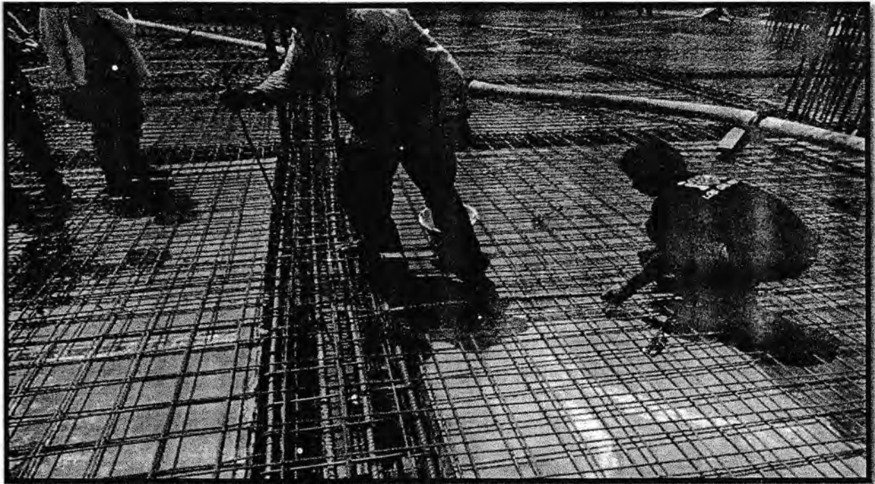
Gambar. Pemasangan Batu tahu
