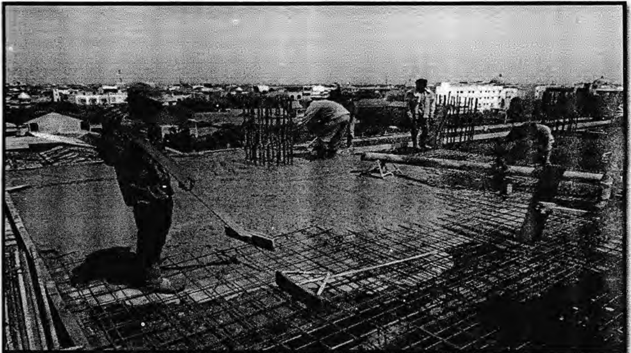
Gambar. Perataan Beton Cor
