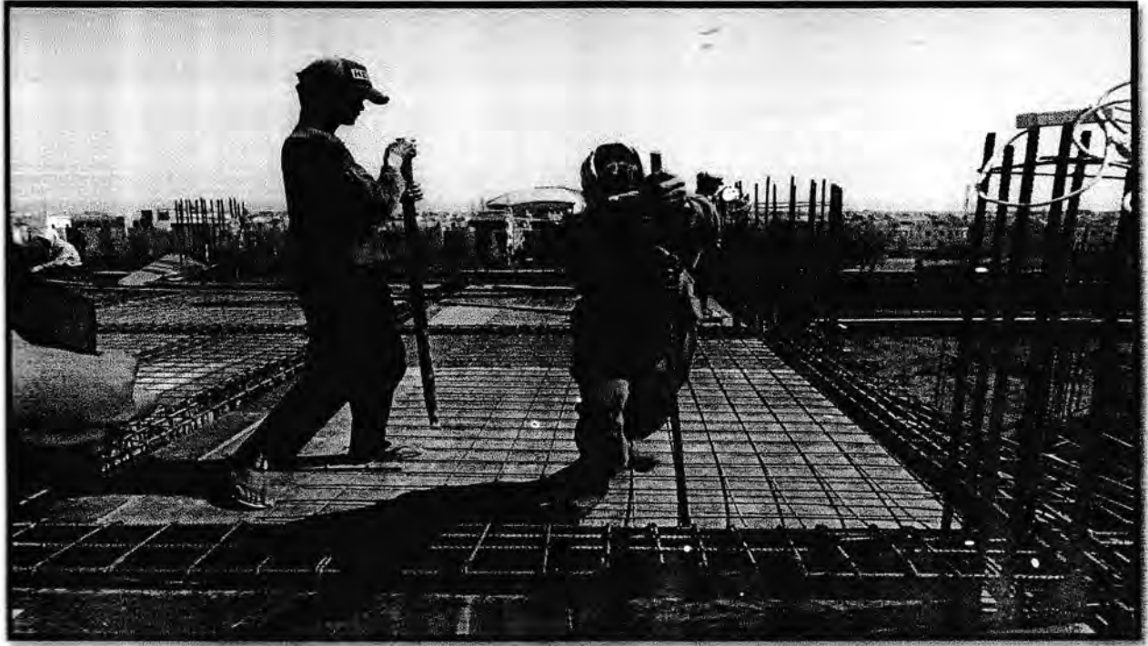
Gambar. Pemasangan Plat Wiremesh
