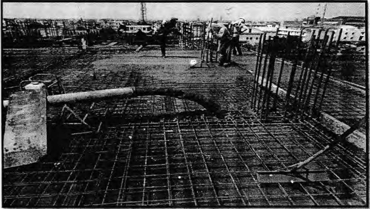
Gambar. Pengecoran Plat lantai
