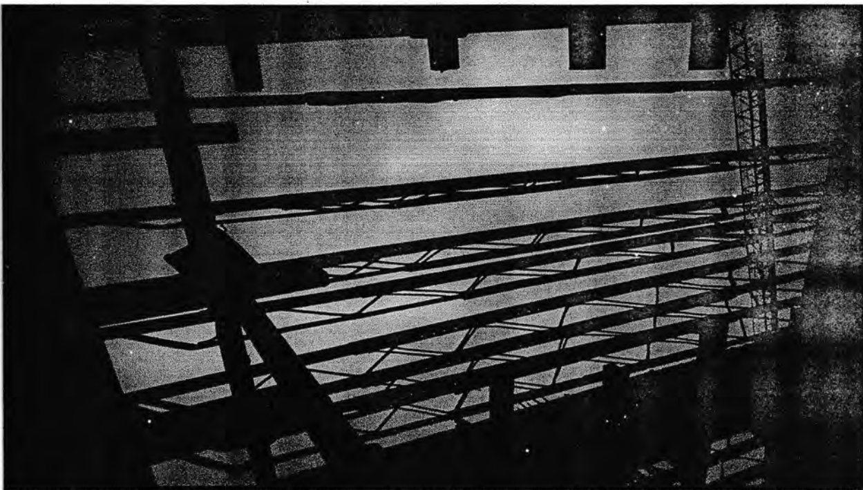
Gambar. Pemasangan orimbim
