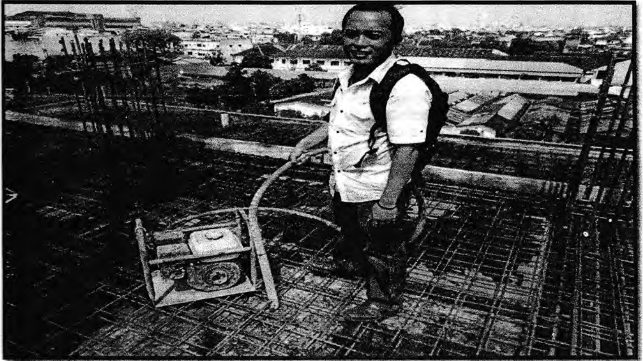
Gambar. Mesin Vibrator Alat untuk Pematatan Beton
