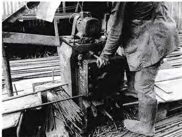
Gambar 2. Pemotongan besi tulangan
