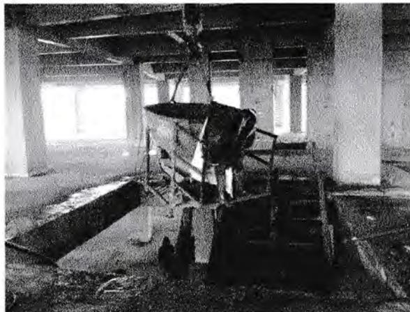
Gambar 42. Pengecoran tangga
