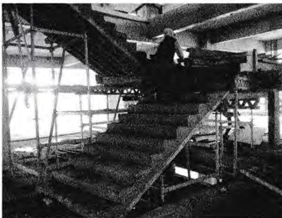
Gambar 45. Pembongkaran bekisting tangga
