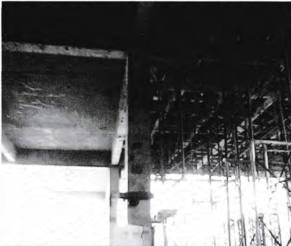
*Gambar: 3.1.4.d pembongkaran bekisting pada plat lantai*
