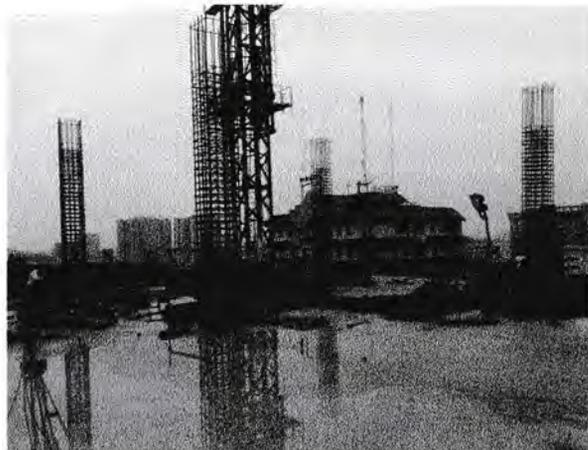
Gambar 22. Pemasangan / penempatan tulangan kolom
