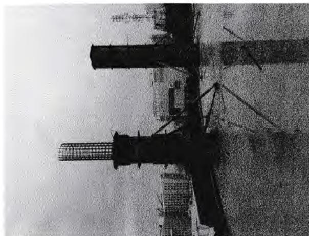
Gambar 23. Pemasangan bekisting kolom
