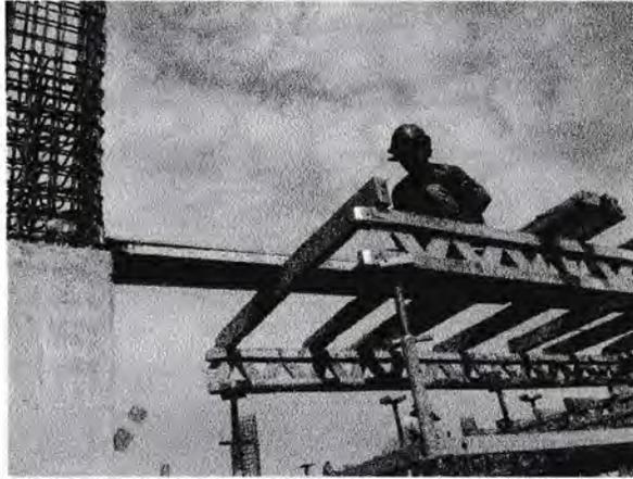
Gambar 3. Menentukan as balok pada kolom
