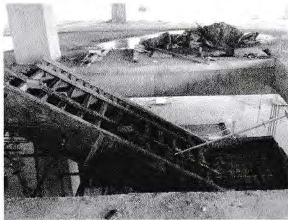
Gambar 41. Pemasangan scafholding tangga
