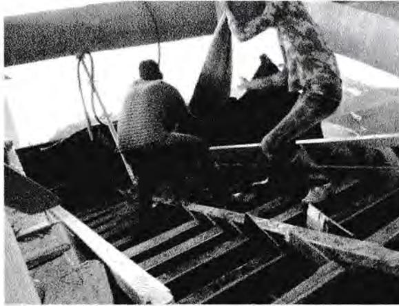
Gambar 43. Pengecoran tangga
