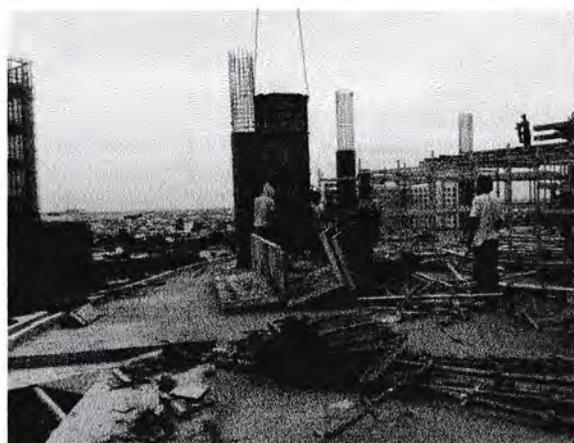
Gambar 36. Pembongkaran bekisting kolom
