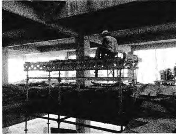
Gambar 40. Pemasangan scafholding tangga
