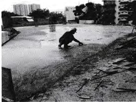
Gambar 12. Pengerjaan perataan pengecoran
