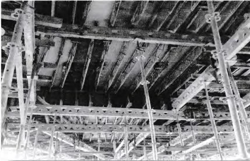
*Gambar: 3.1.1. Pemasangan bekisting plat lantai*
