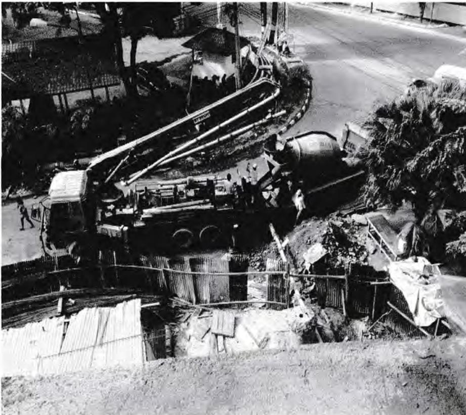
***Gambar: 3.1.4.a Pengerjaan pengangkutan cor beton***
