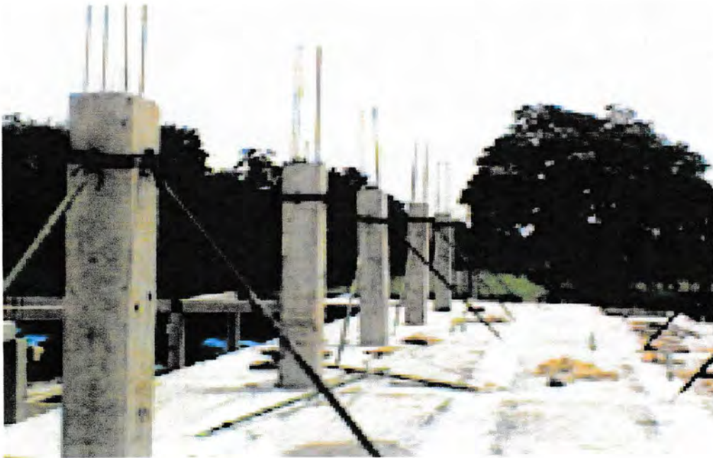
Penyetelan kolom dengan menggunakan ( Ajus steable) agar lurus
