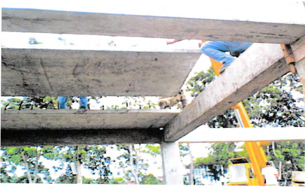
Pengangkatan dan penyetelan lantai
