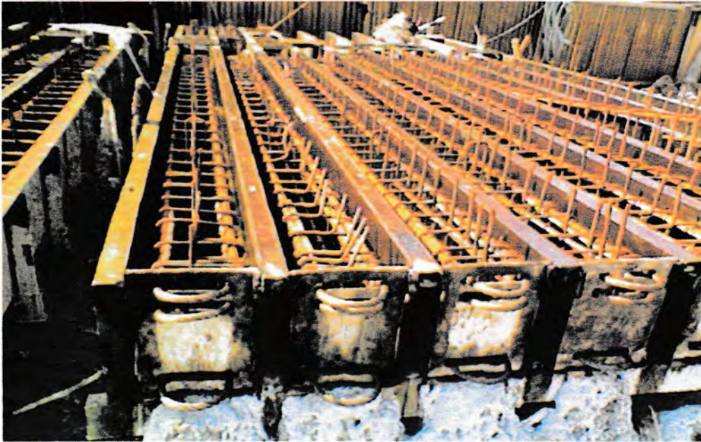
ESCAFOULDING Pada saat pencetakan balok
