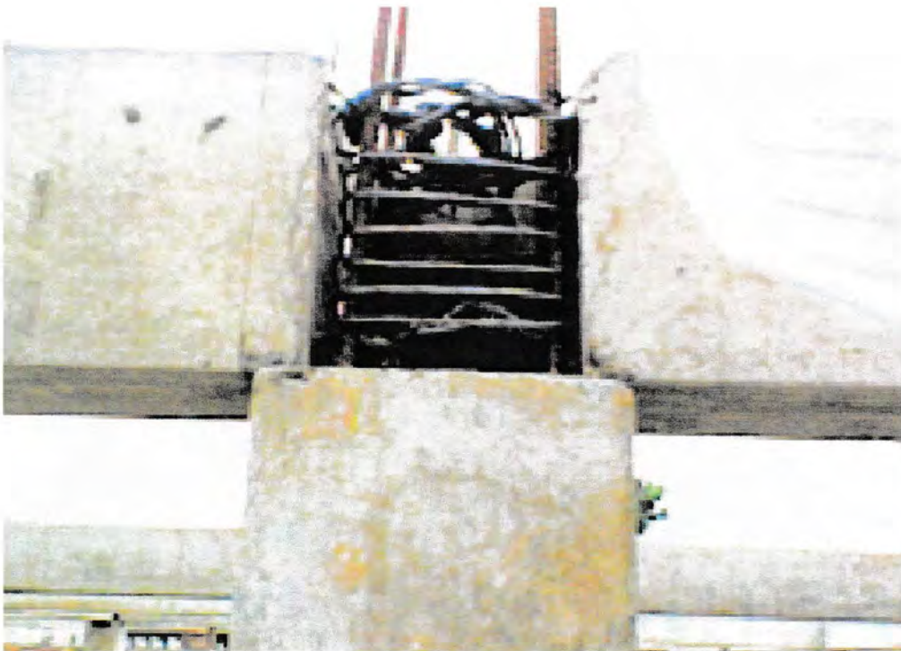
Sambungan antara balok dan balok
