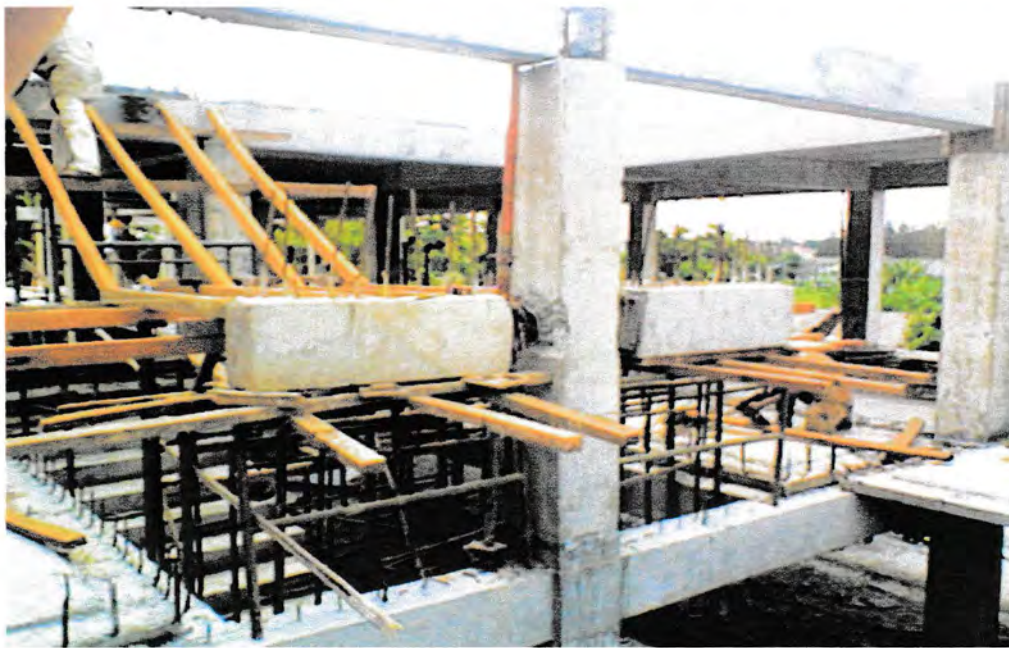
Penyetelan pada balok anak tangga
