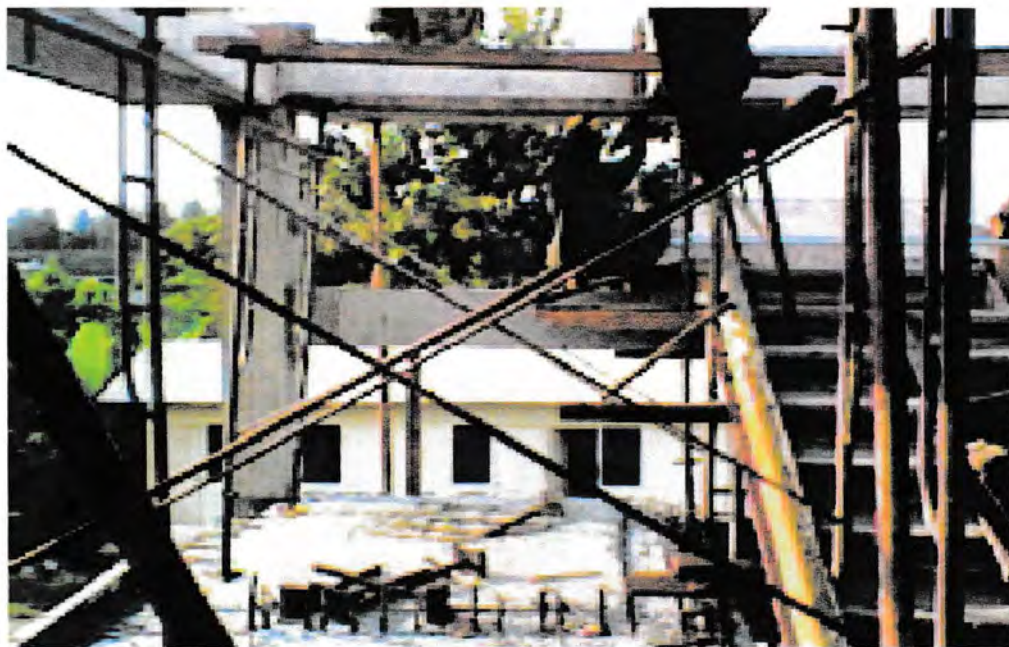
Gambar tangga pada lantai III
