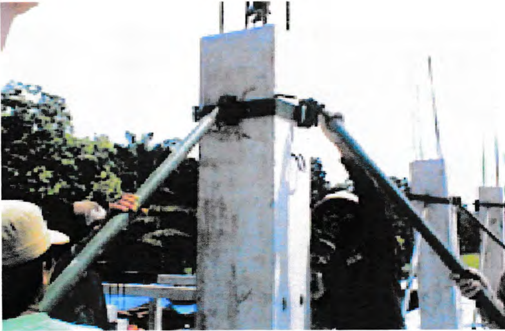
Penyetelan kolom dengan menggunakan ( Ajus steable) agar lurus
