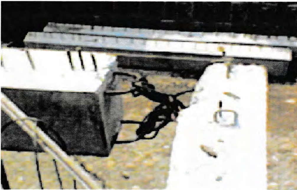
Sambungan antara balok induk dan balok anak pada balcon
