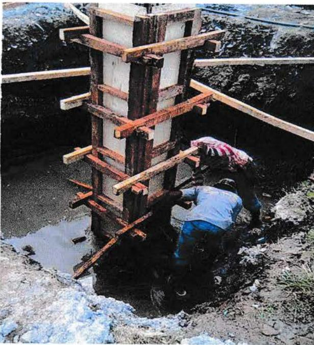
**Gambar 4.2.5 Pemasangan Papan Kayu Bekisting**
