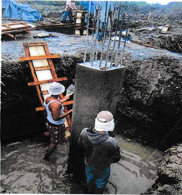
**Gambar 4.2.7 Pembongkaran Bekisting**
