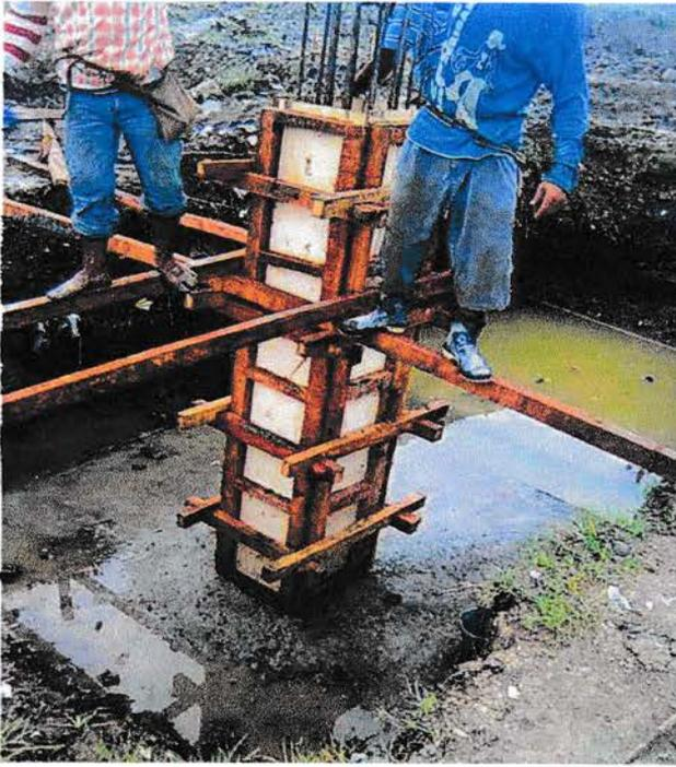
**Gambar 4.2.6 Pengecoran Kolom**
