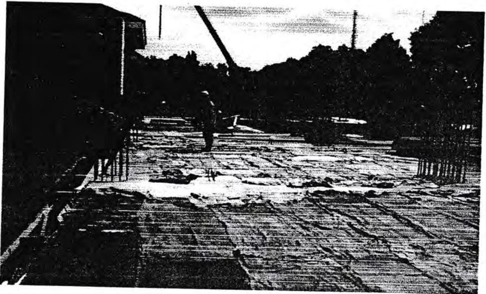
*Gambar Perawatan Beton Setelah Selesai di Cor*
