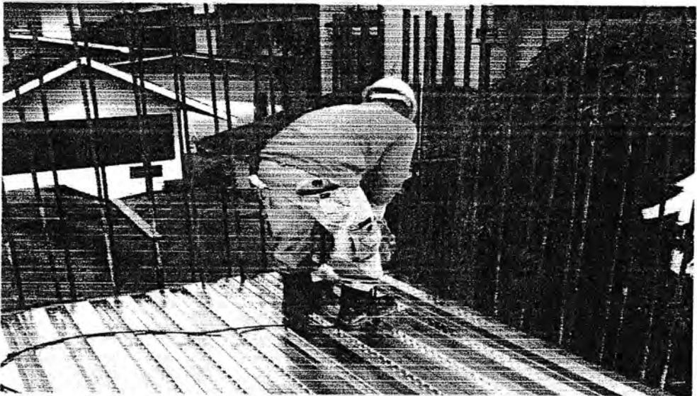
*Gambar Pemotongan Plat Bondek Yang melebihi Ukuran.*
