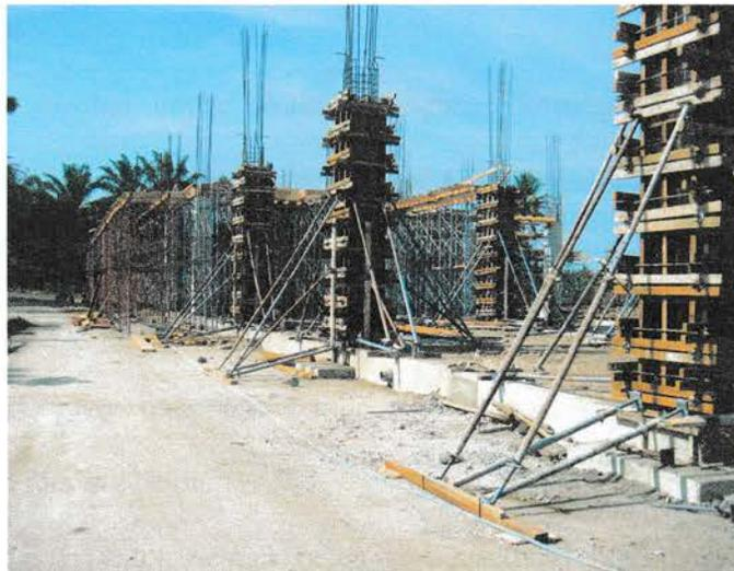
**Gambar 3.6 :** Pemasangan bekisting balok dan kolom.
