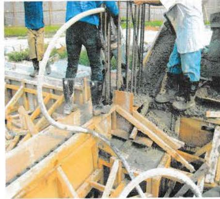
**Gambar 4.2: Proses Pembetonan dengan Truk Molen Concrete Vibrator**      **Gambar 4.3 : Pematatan**
