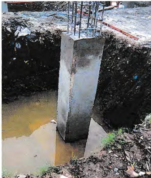
Gambar 4.2.7 Hasil Setelah Pemongkaran Bekisting
