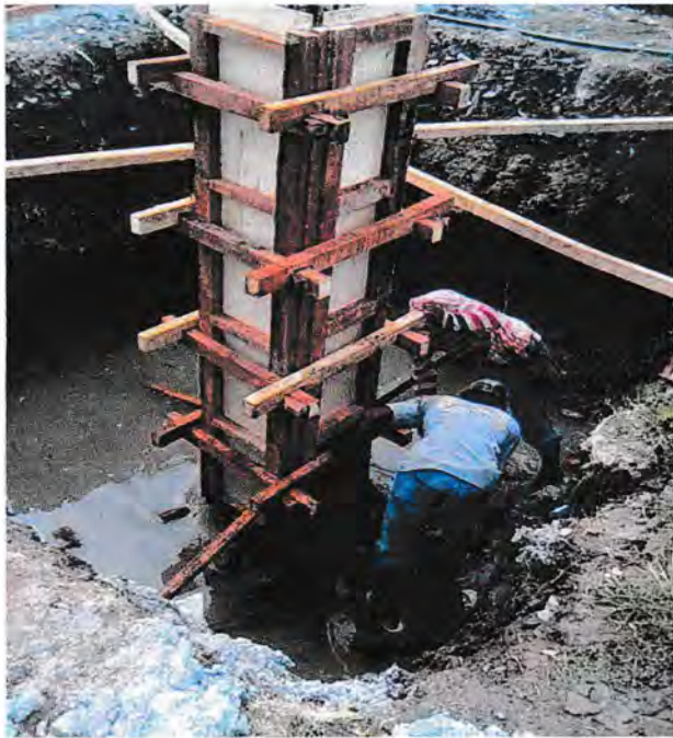
Gambar 4.2.5 Pemasangan Papan Kayu Bekisting
