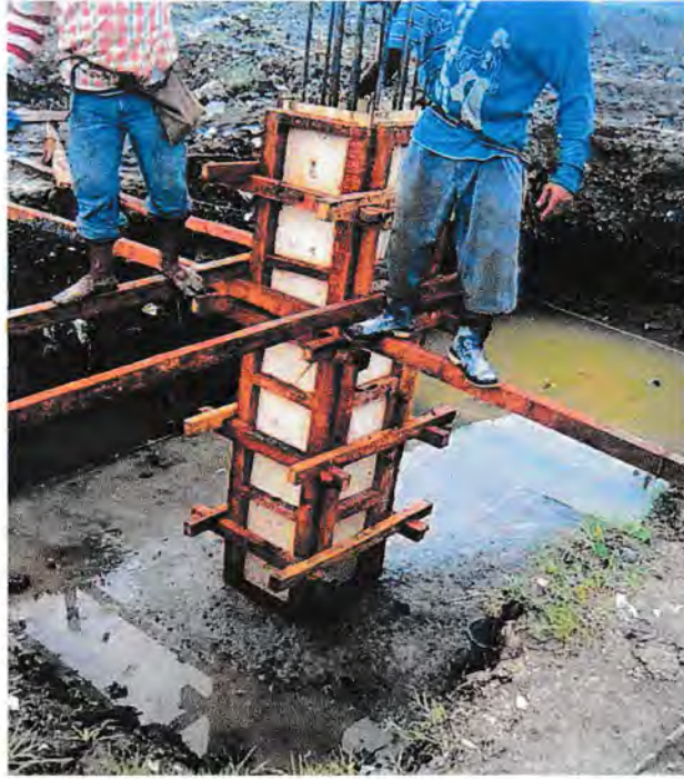
Gambar 4.2.6 Pengecoran Kolom
