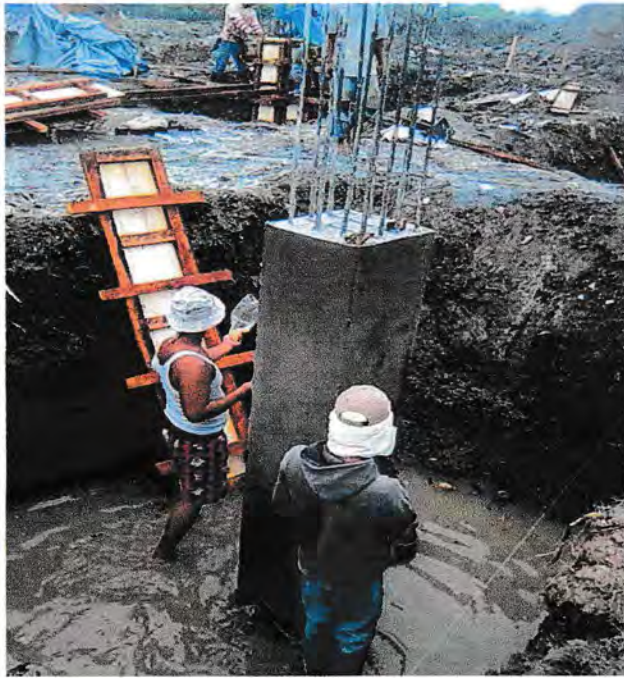
Gambar 4.2.7 Pembongkaran Bekisting
