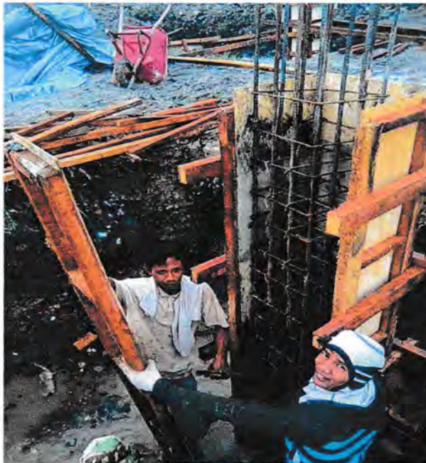
Gambar 4.2.5 Pemasangan Bekisting Bahan Kayu
