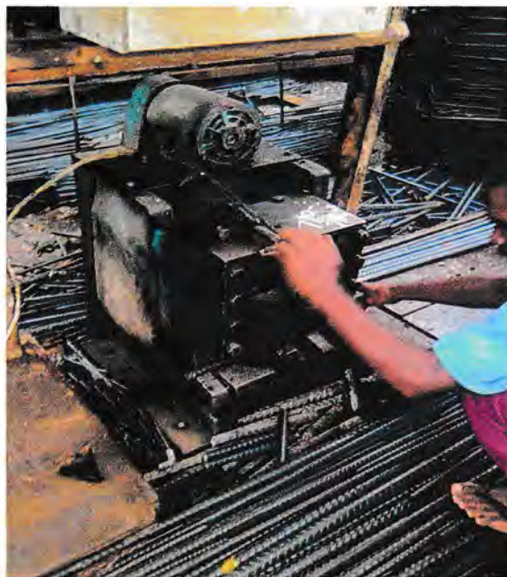
Gambar 4.2.3 Pekerjaan Pemotongan Besi
