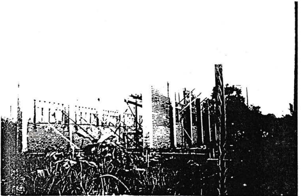
Pemasangan pasangan bata dan penyetelan kosen jendela.
