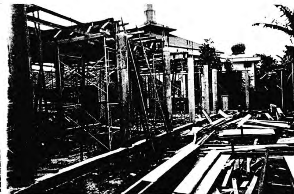
Bekisting Balok dan Pelat Lantai bertingkat
