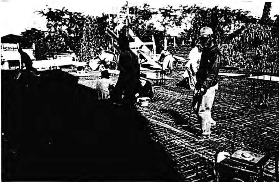
Pembesian Balok dan Pelat Lantai bertingkat
