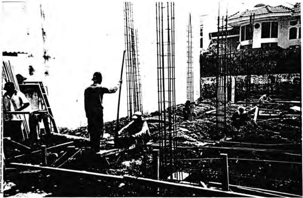
Struktur Kolom Penopang Balok dan Pelat Lantai bertingkat
