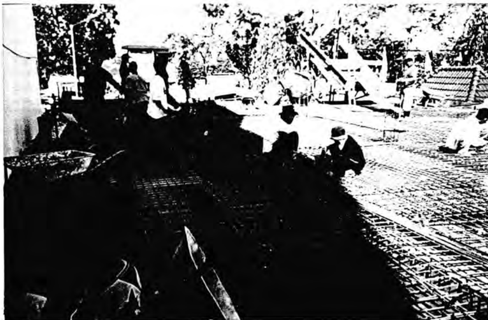
Pembesian Balok dan Pelat Lantai bertingkat
