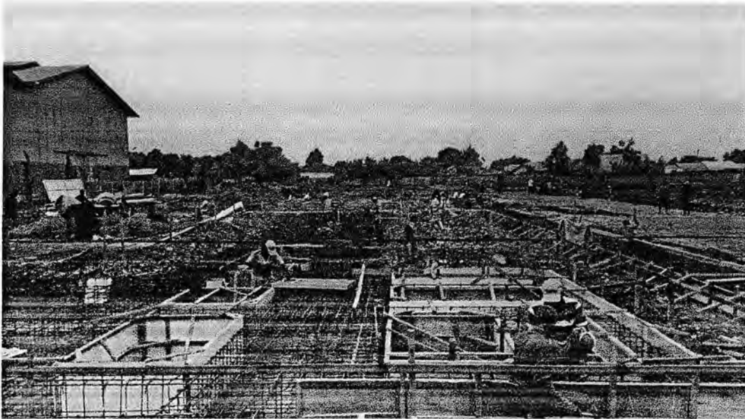
Foto Pekerjaan Pembesian Pondasi Form Work Box Girder
