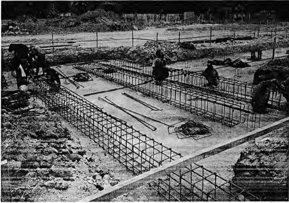
Foto Perakitan Tulangan Gantry Crane
