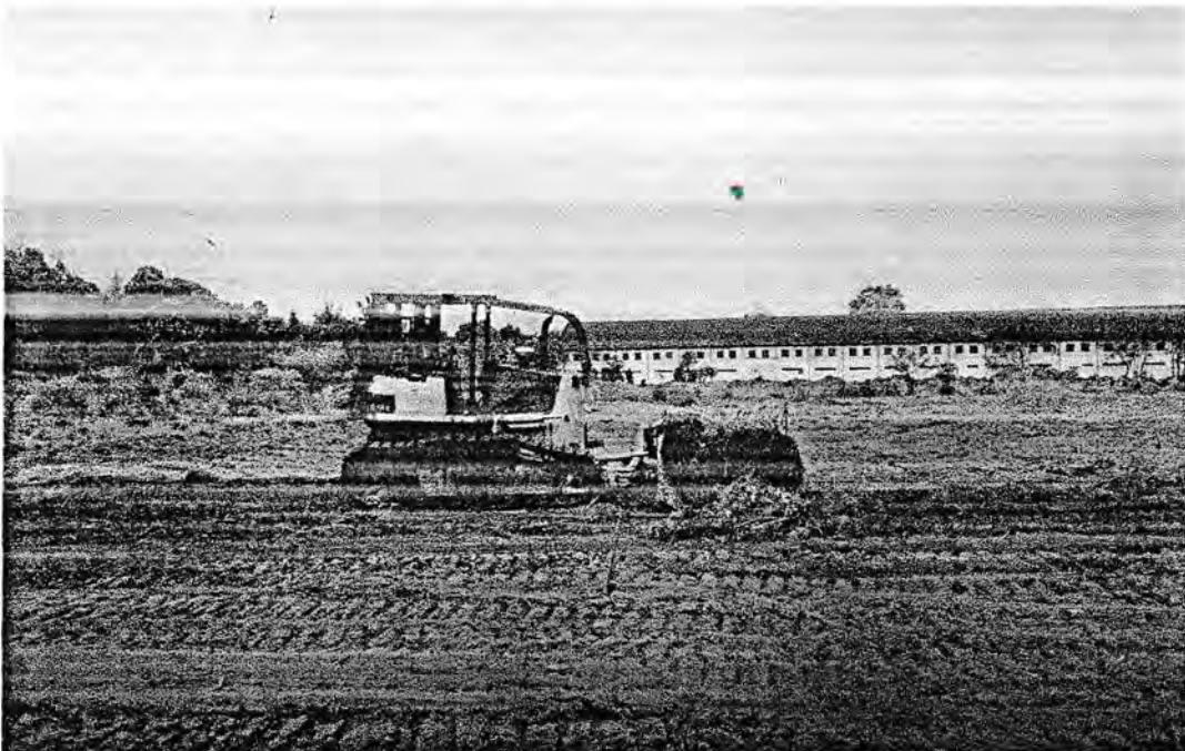
Foto Pembersihan Lapangan Menggunakan Eskapator
