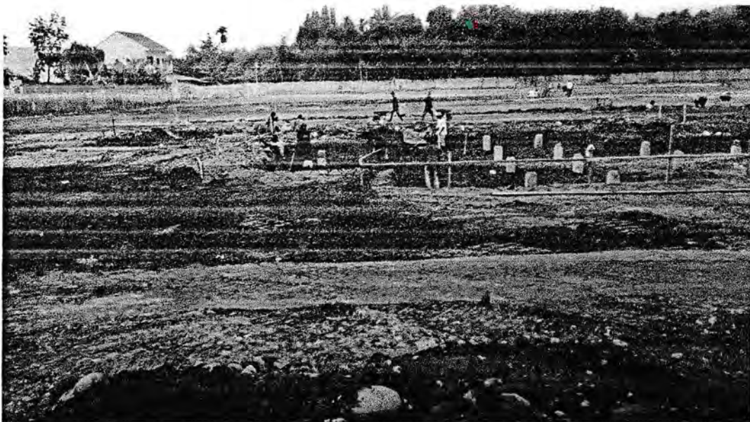
Foto Pekerjaan Galian Tanah Setelah Pemancangan
