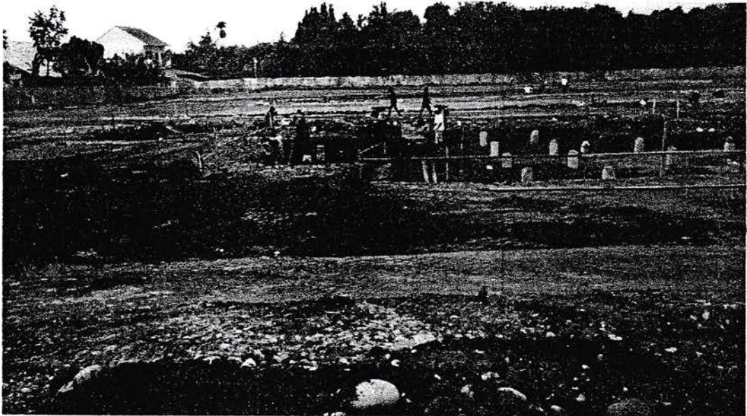
Foto Pekerjaan Galian Tanah Setelah Pemancangan
