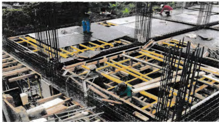
Pemasangan Bekisting Plat Lantai
