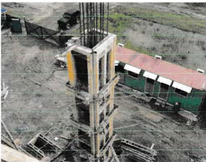
Pemasangan Bekisting Kolom
