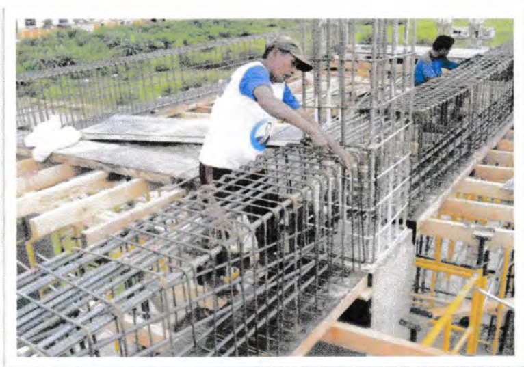
Pembesian Balok Lantai
