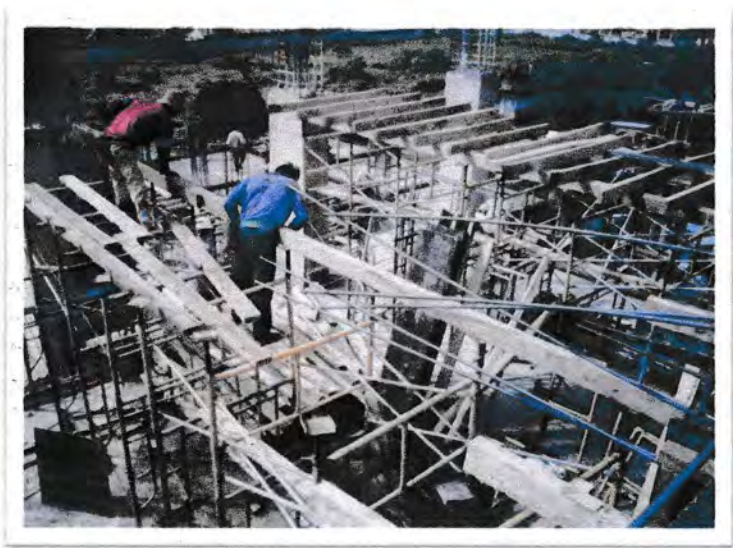
Pekerjaan Bekisting Lantai
