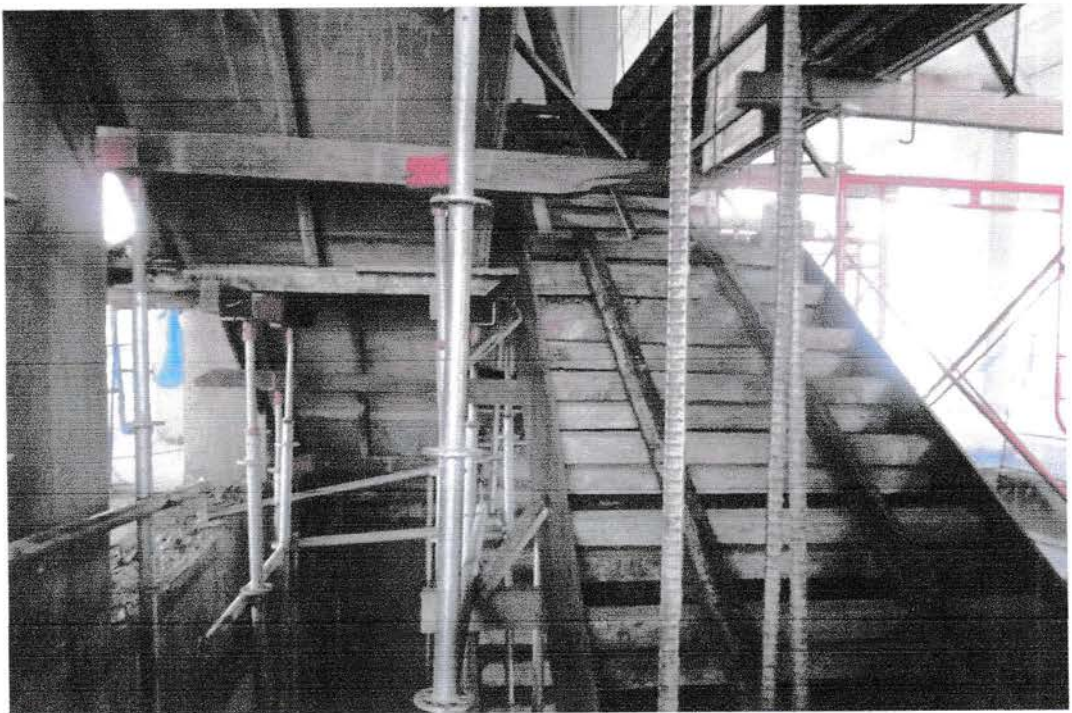
Gambar 3.2 bekisting tangga
