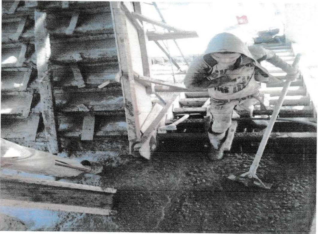
Gambar 3.3 Pengecoran tangga
