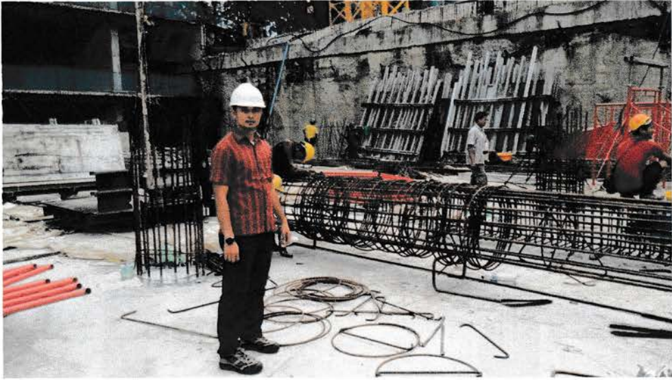
L.1 Pabrikasi Besi
