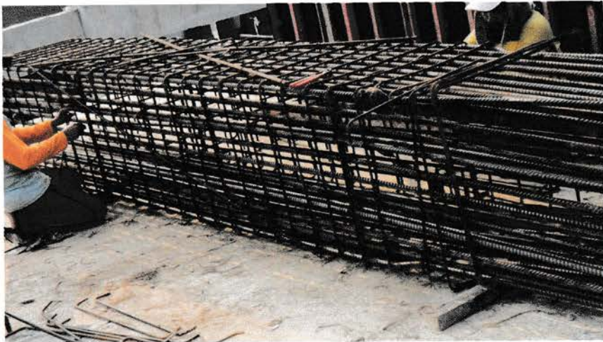
Gambar 3.19 Pekerjaan pabrikasi besi
