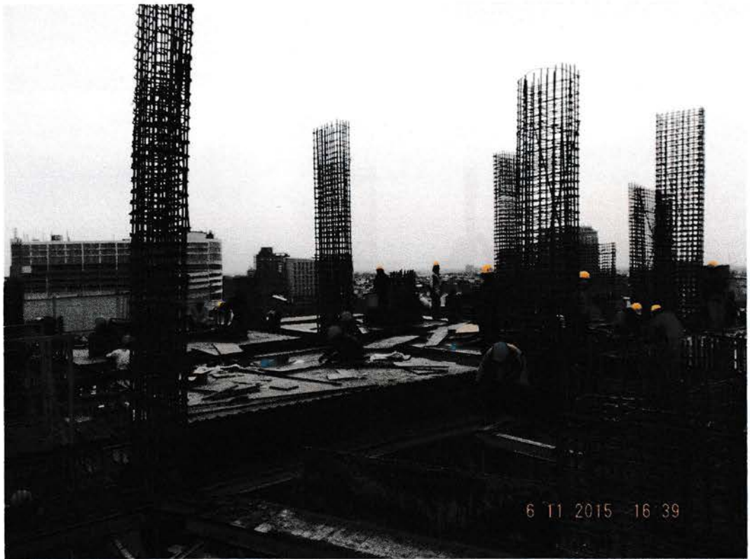
L.4 Instal Besi Kolom
