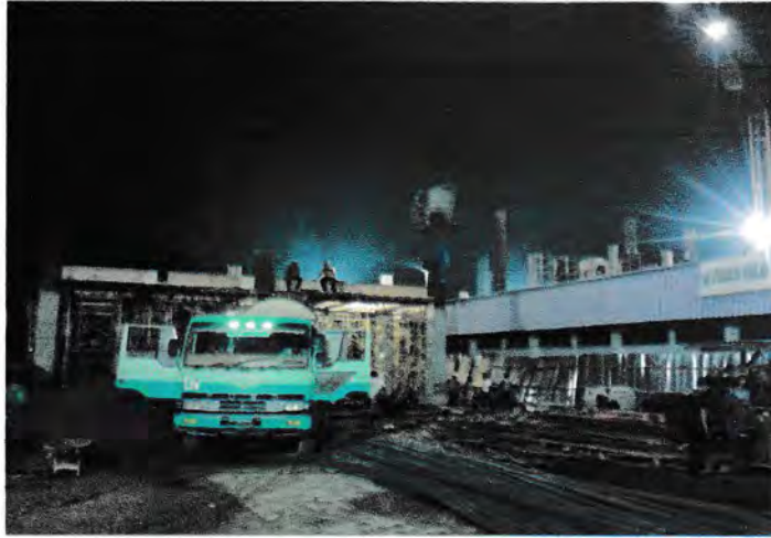
Gambar 3.8. pekerjaan adukan beton
