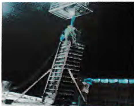
Gambar 3.1. Bekisting kolom (bekisting dinding peri)
