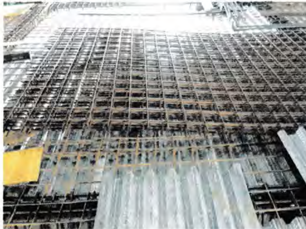
Gambar 3.7. Tulangan plat lantai
