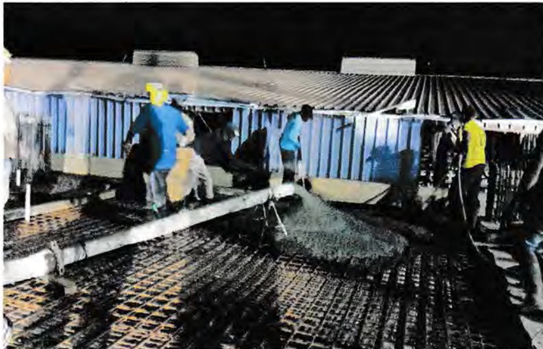
Gambar 3.9. pekerjaan pengecoran
