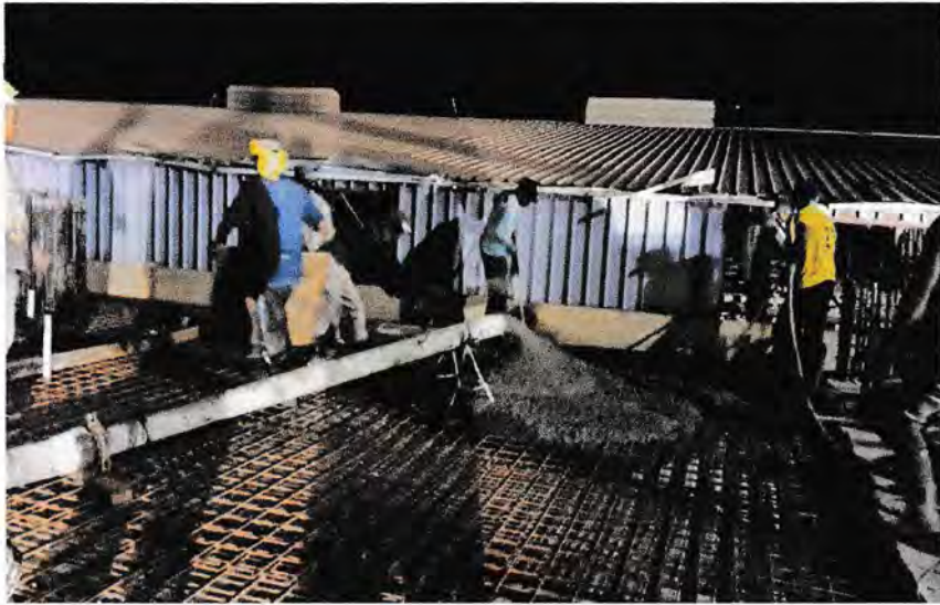
Gambar 3.9. pekerjaan pengecoran
