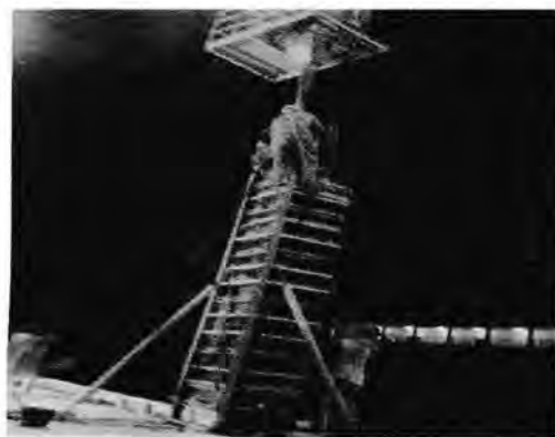
Gambar 3.1. Bekisting kolom (bekisting dinding peri)
