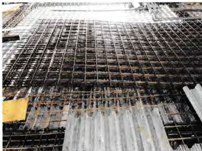
Gambar 3.7. Tulangan plat lantai
