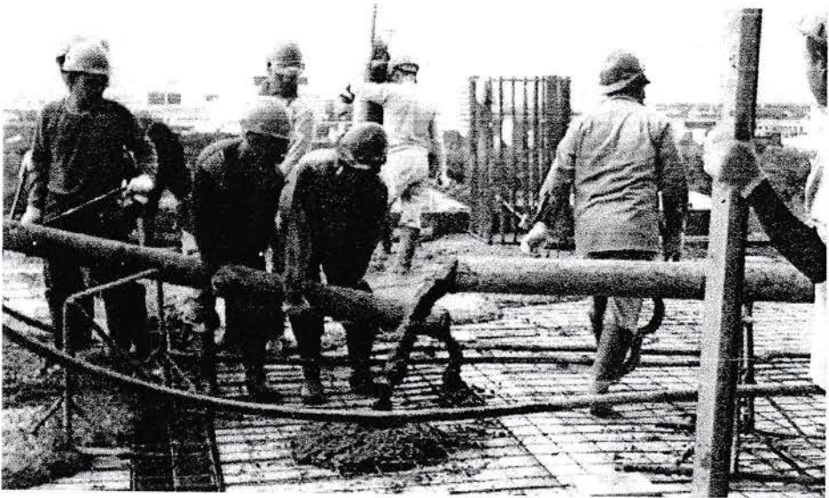
Gambar 4.22 Pengecoran Plat Lantai Sumber : Data Lapangan 2014
