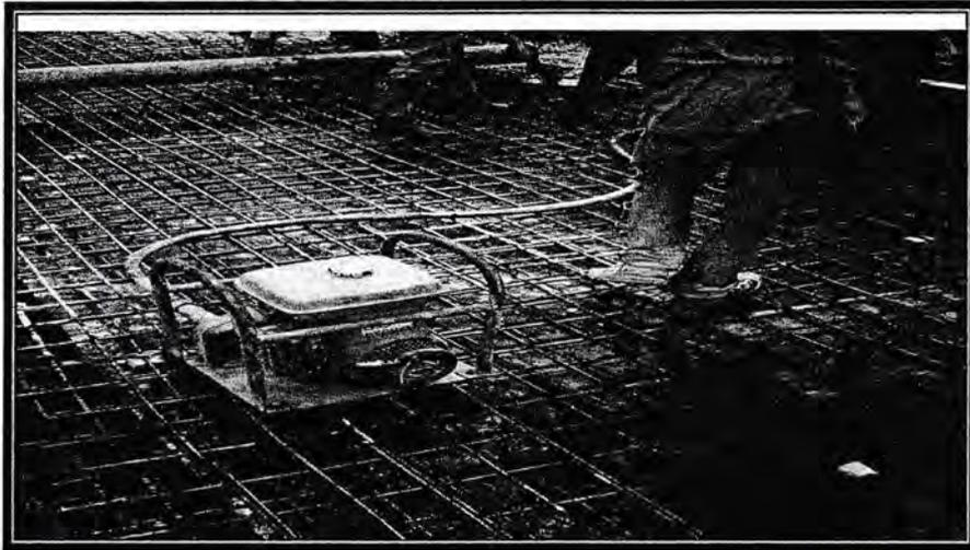
**Gambar 4.3 Mesin Vibrator**
