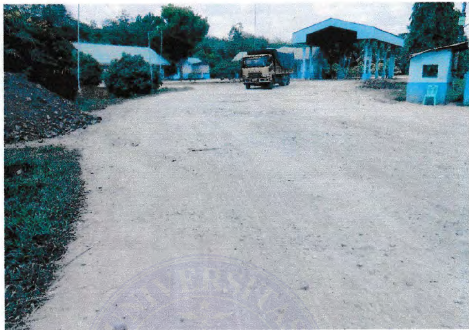
Gambar Gedung UPPKB Mambang Muda
