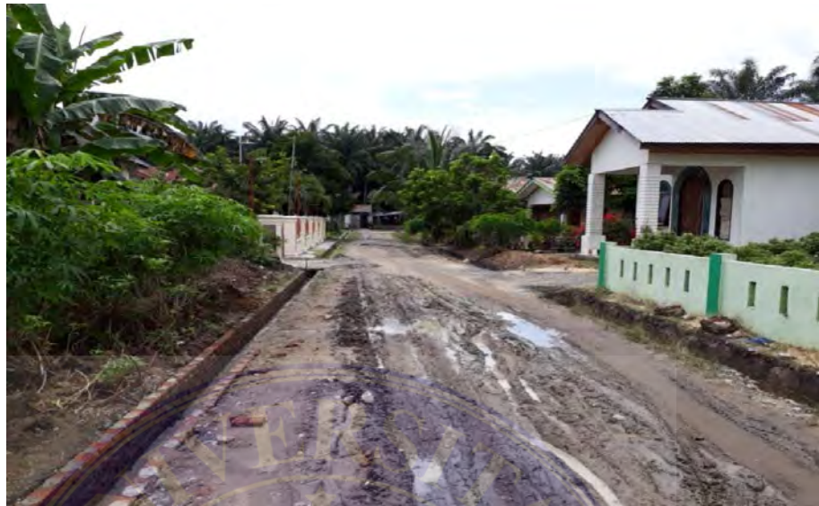
Gambar 3: Pembuatan Parit Beton Desa Asam Jawa
