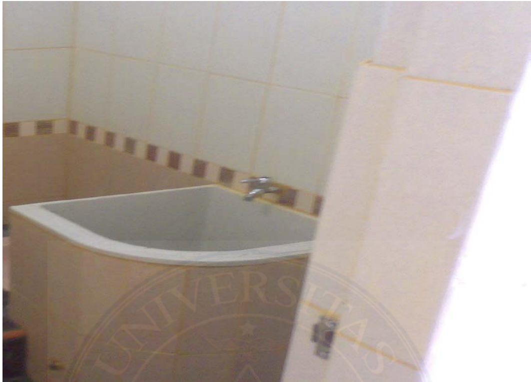
Gambar 4. Pekeraan Kamar Mandi/WC Tahun 2011 Sumber : Data Lapangan
