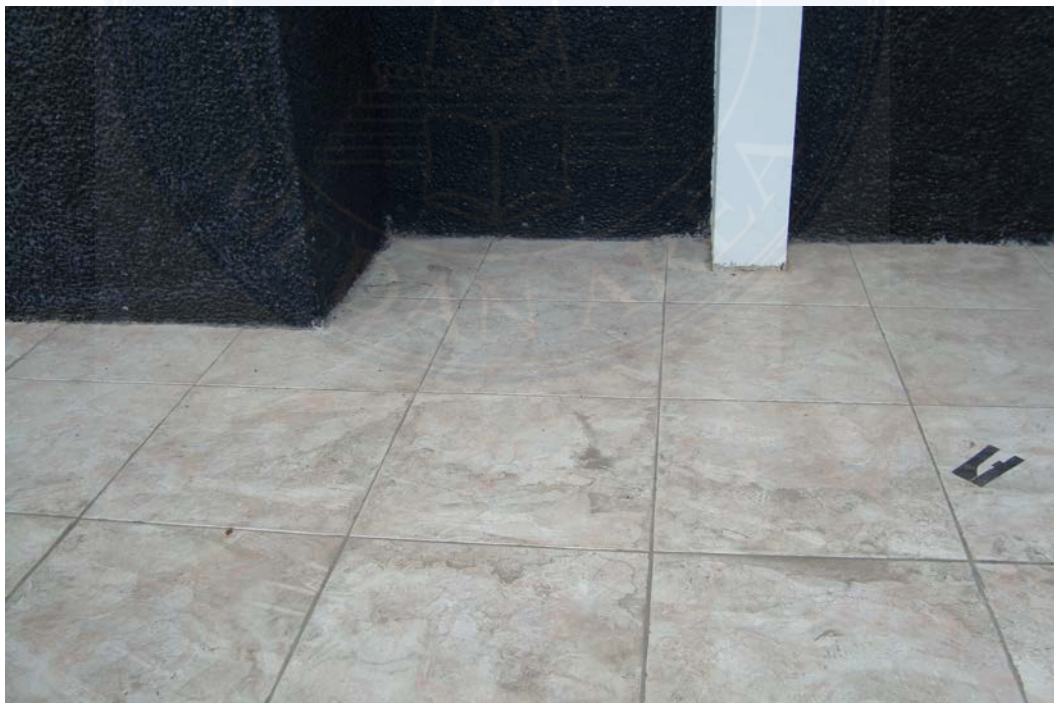
Gambar 9. Pekerjaan Lantai Keramik Tahun 2011 Sumber : Data Lapangan
