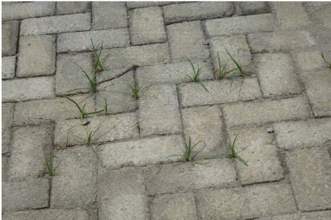
Gambar 11. Pekerjaan Paving Block Tahun 2011 Sumber : Data Lapangan
