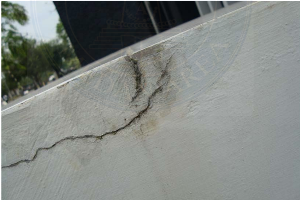
Gambar 5. Pekerjaan Plesteran Dinding Bata Luar Tahun 2011 Sumber : Data Lapangan
