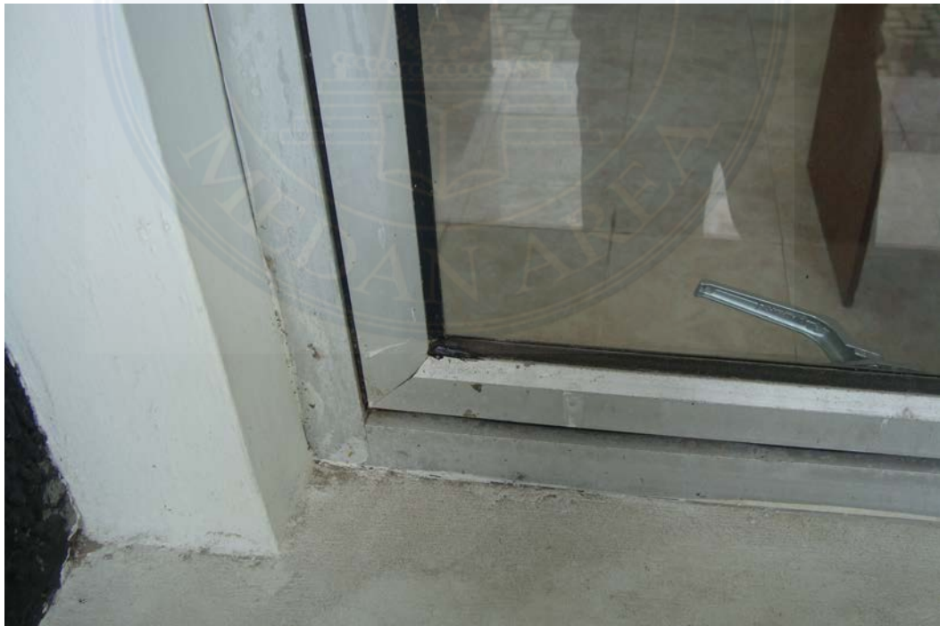
Gambar 3. Pekerjaan Kusen Jendela Tahun 2011 Sumber : Data Lapangan
