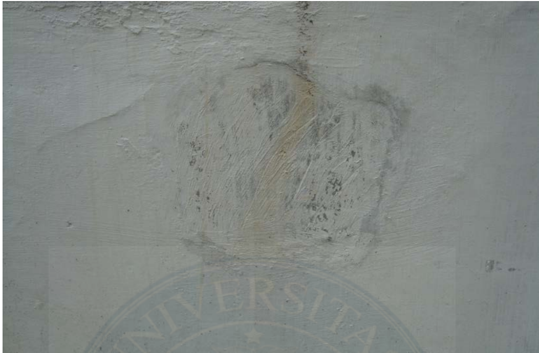
Gambar 6. Pekerjaan Plesteran Dinding Bata Dalam Tahun 2011 Sumber : Data Lapangan
