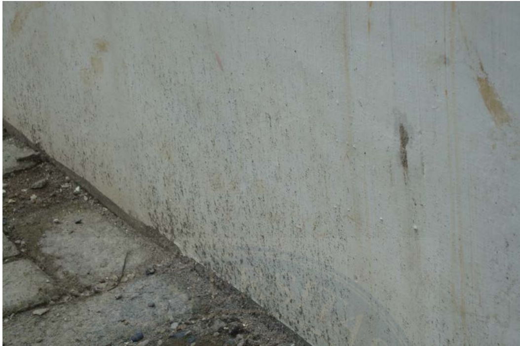
Gambar 8. Pekerjaan Pengecatan Bagian Luar Tahun 2011 Sumber : Data Lapangan
