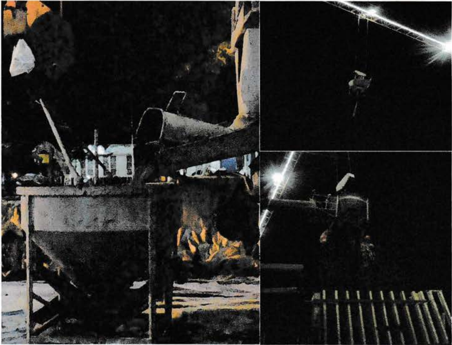
Gambar.4.4. Pekerjaan pengecoran kolom
