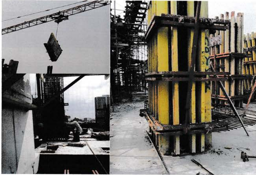
Gambar 3.1. Bekisting kolom (bekisting dinding peri)
