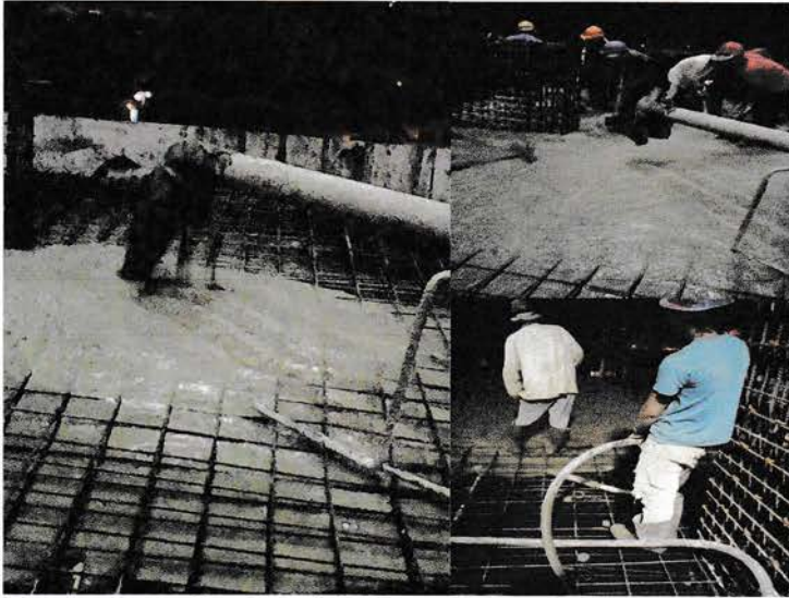
Gambar 4.6. : Pengecoran plat lantai
