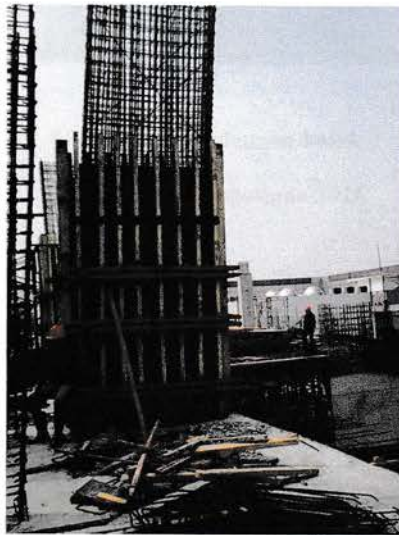
Gambar : Tulangan kolom
