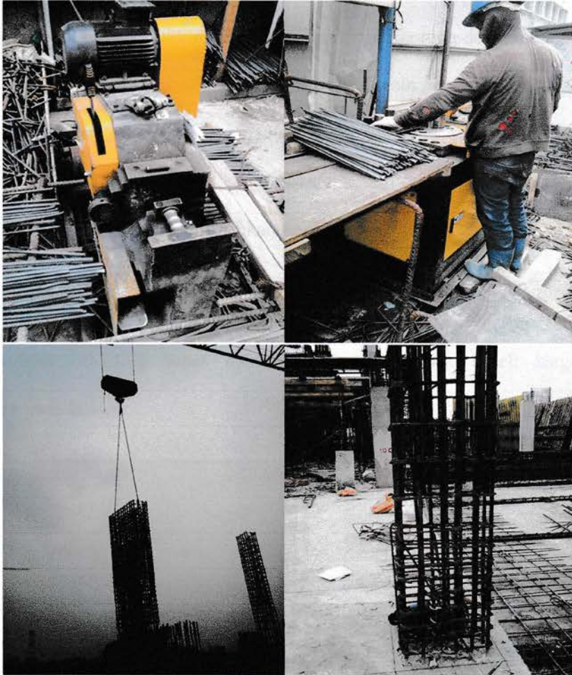
Gambar 4.1. Pemotongan dan pembentukan besi tulangan
