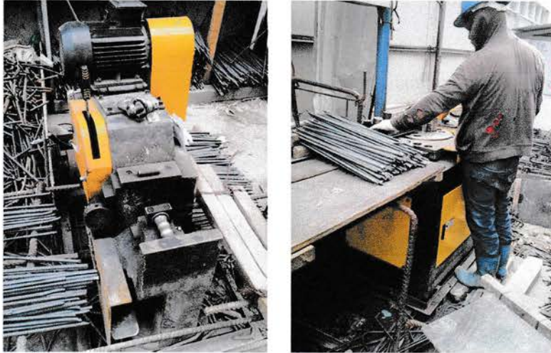
Gambar 3.4. Pekerjaan pemotongan dan pembengkokan tulangan
