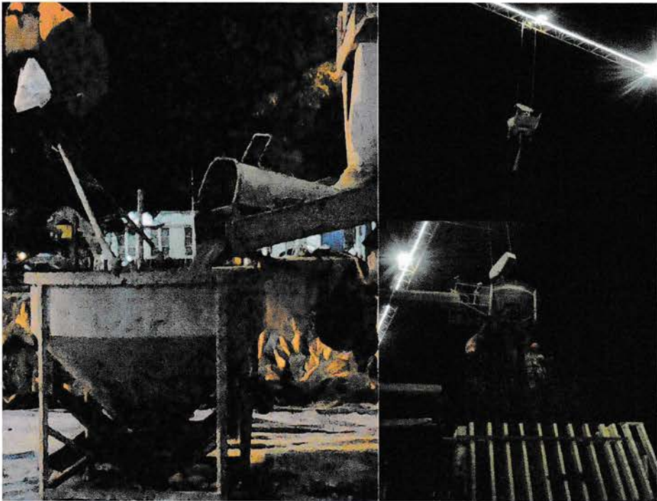
Gambar 3.9. Pekerjaan pengecoran kolom
