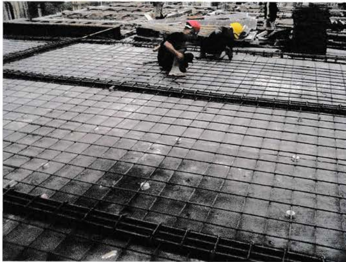
Gambar : 3.3. Bekisting Plat Lantai
