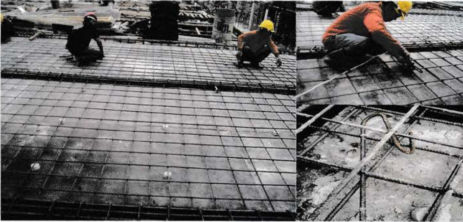
Gambar 3.7. Tulangan plat lantai
