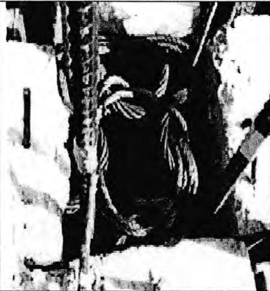
*Pemasangan kabel sling ukuran 8mm untuk menyambungkan balok dengan kolom.*
