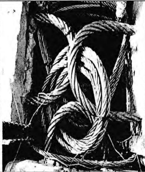
*Pemasangan kabel sling ukuran 8mm untuk menyambungkan balok dengan kolom.*
