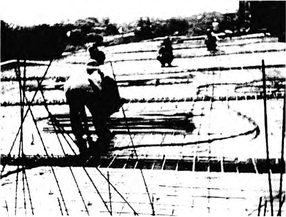
h. Pelaksanaan Pemasangan Tulangan Lantai
