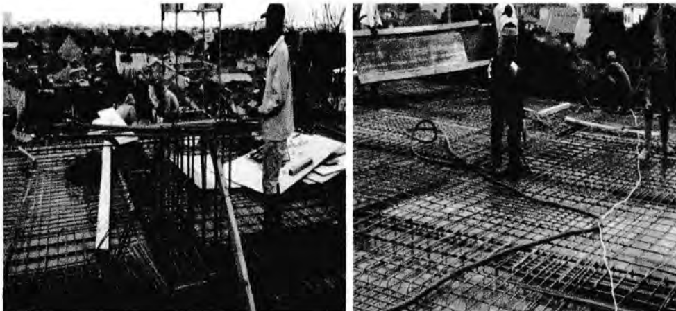
Gambar : Pekerjaan Pembesian plat lantai
