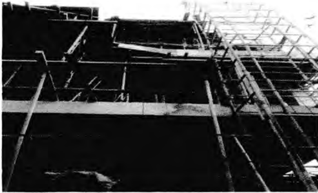
Gambar : Pemasangan Scaffolding untuk Molen Hidrolik
