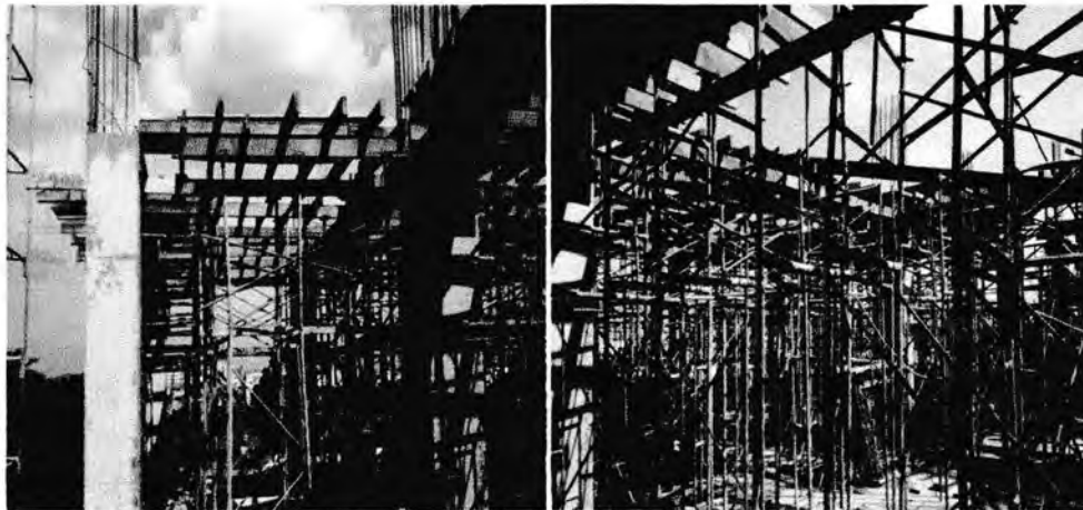
Gambar : Pemasangan Bekisting Ring Balok
