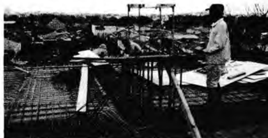
Gambar : Pekerjaan Pembesian Ring Balok dan Plat Lantai
