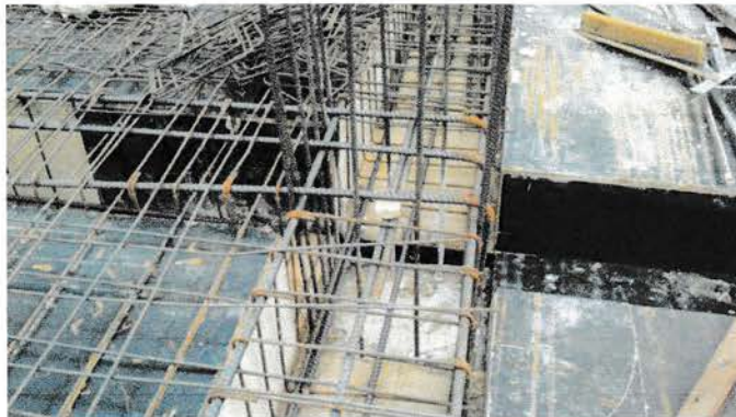
Gambar 2.10 Pekerjaan pembesian pada ring balok dan plat
