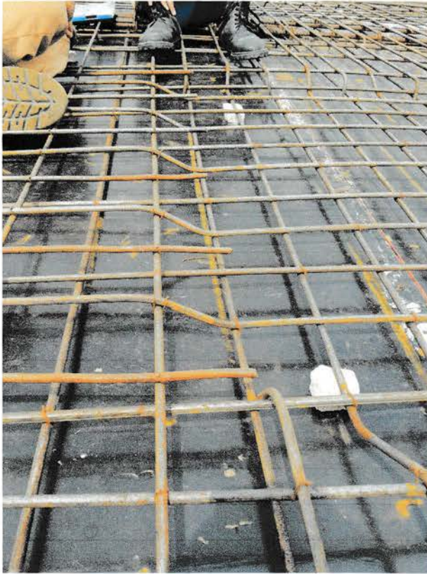
Gambar : Sambungan besi tulangan pelat lantai
