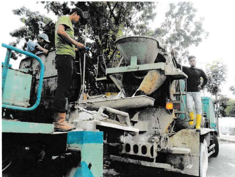
Gambar : Pengacoan semen menggunakan truck molen
