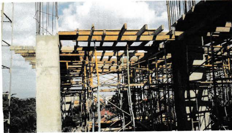
Gambar : Peranca untuk pengecoran pelat lantai
