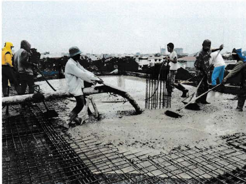
Gambar : Pengecoran pelat lantai menggunakan Pump Concrete
