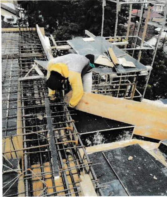
Gambar : Penulangan besi balok B6
