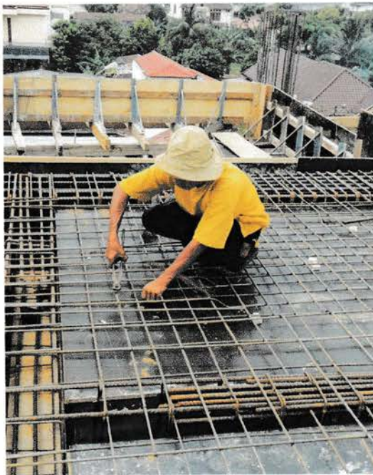
Gambar : Penulangan besi pelat lantai
