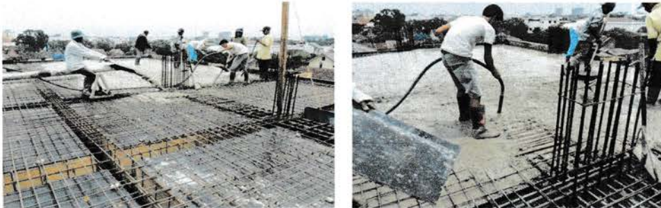
Gambar 2.11 Pengecoran pada Pelat Lantai
