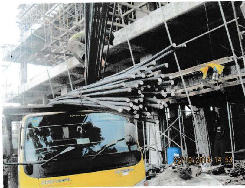
Gambar : Besi tulangan yang dipergunakan
