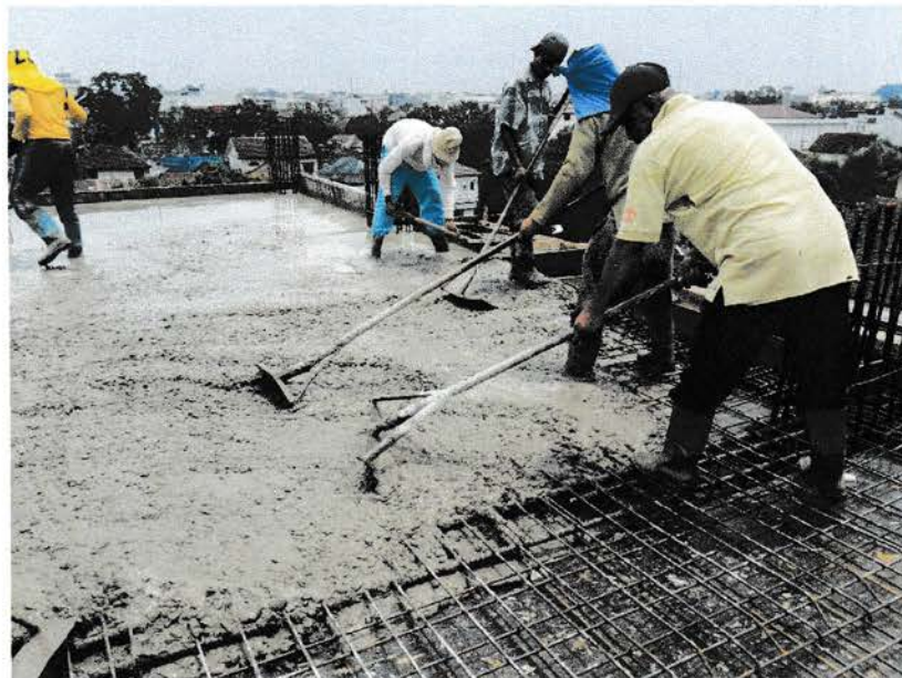
Gambar : Meratakan pengecoran pelat lantai
