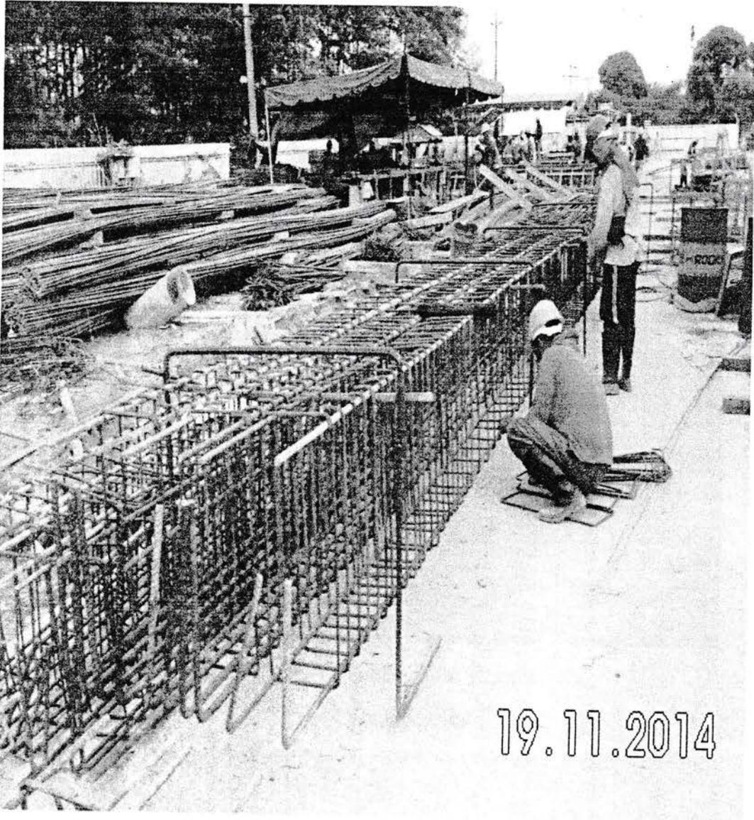
Gambar : Penulangan besi balok
