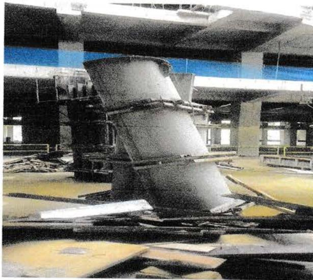
Gambar 2.13 Cetakan Kolom
