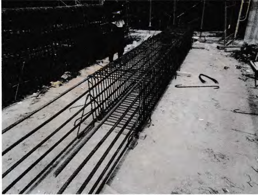
Gambar : Perakitan penulangan kolom dipabrikasi
