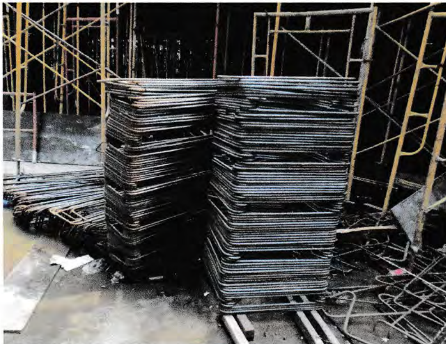
Gambar : Perakitan penulangan kolom dipabrikasi
