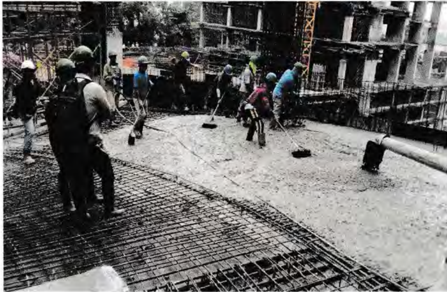
Gambar 2.21 Pengecoran pada Pelat Lantai
