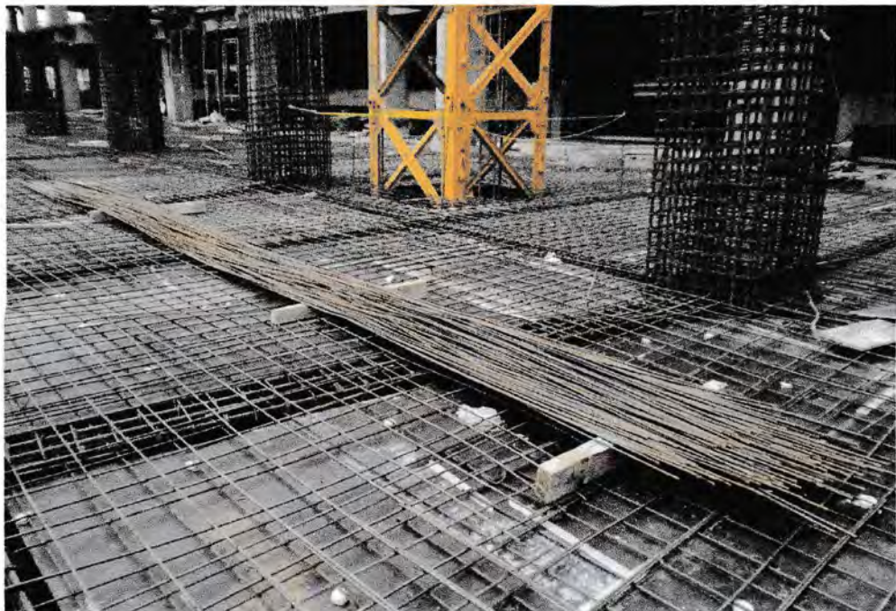
Gambar : Besi D10 yang digunakn untuk penulagan pelat lantai
