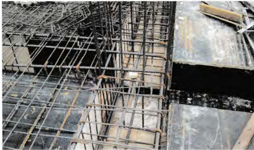
Gambar 2.20 Pekerjaan pembesian pada ring balok dan plat lantai
