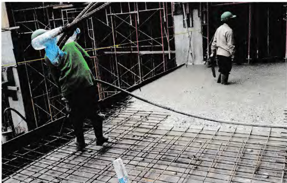
Gambar : Pengecoran pelat lantai dan balok
