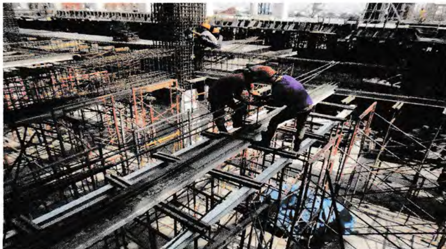
Gambar 2.19 Pekerjaan pembesian pada ring balok dan plat lantai
