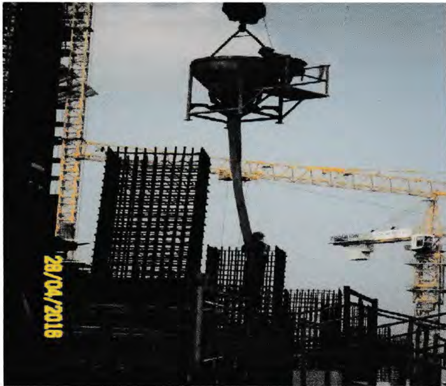
Gambar 2.18 Tiang kolom sedang dicor
