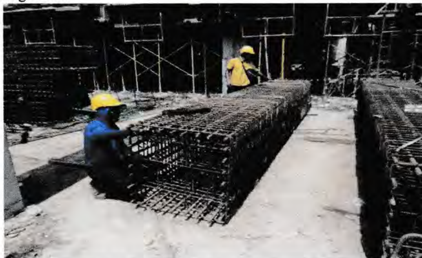
Gambar 2.16 Proses perangkaian besi precast tiang kolom
