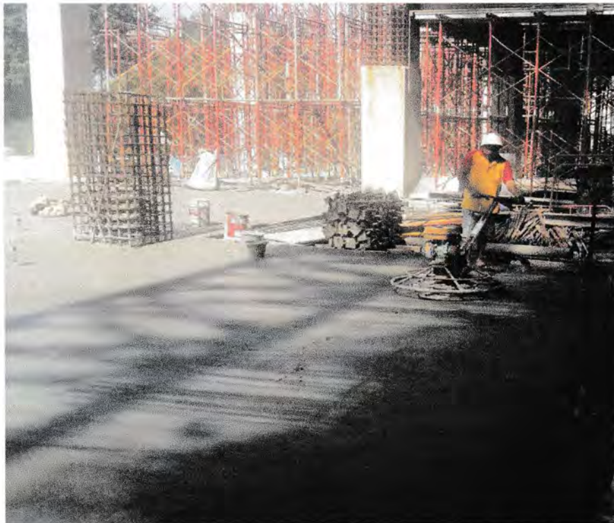
Gambar : Proses meratakan permukaan pelat lantai yang telah dicor dengan mesin Trowel
