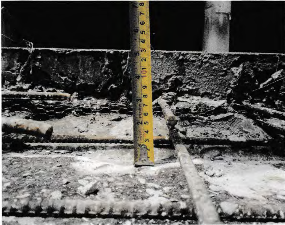
Gambar : Pelat lantai S13 yang telah dilaksanakan
