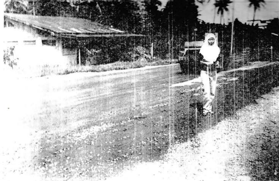
Sedang Di Kerjakan (Pemasangan Sirtu)
