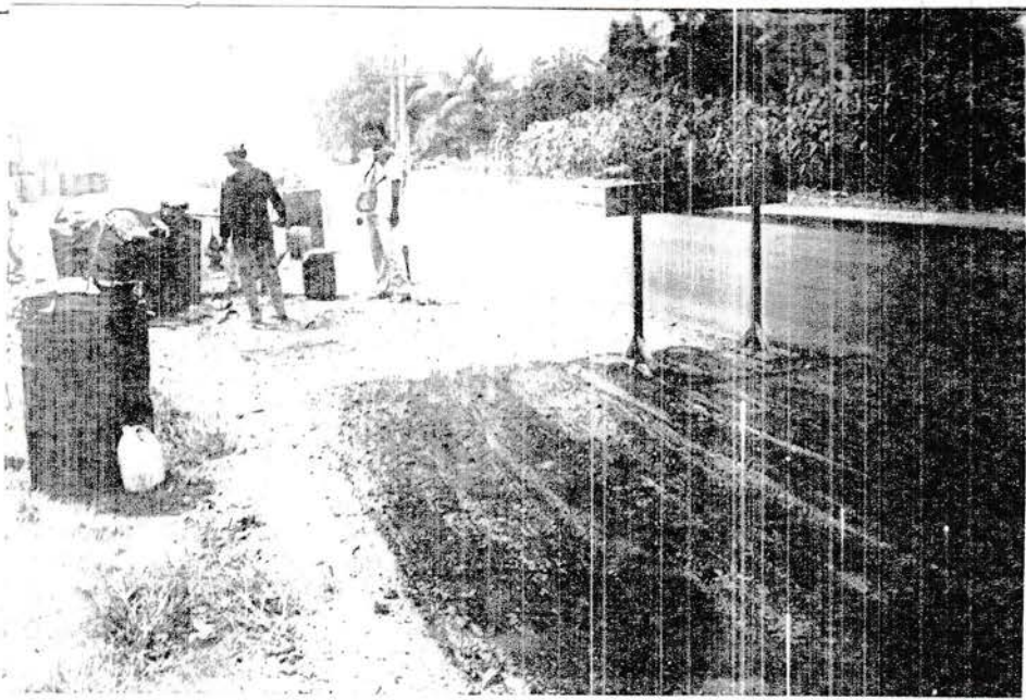
Penyebaran Aspal Emulsi (Track Coat)
